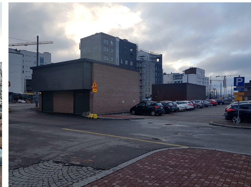
VALOKUVA MESSITYTÖNKUJALTA ETELÄÄN Etualalla kalliopysäköinnin porraskuilu.
