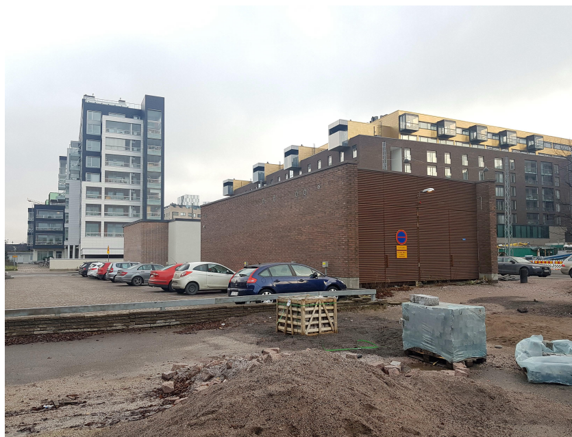
VALOKUVA LAIVAPOJANAUKIOLTA ITÄÄN Etualalla sähköistysasema.
