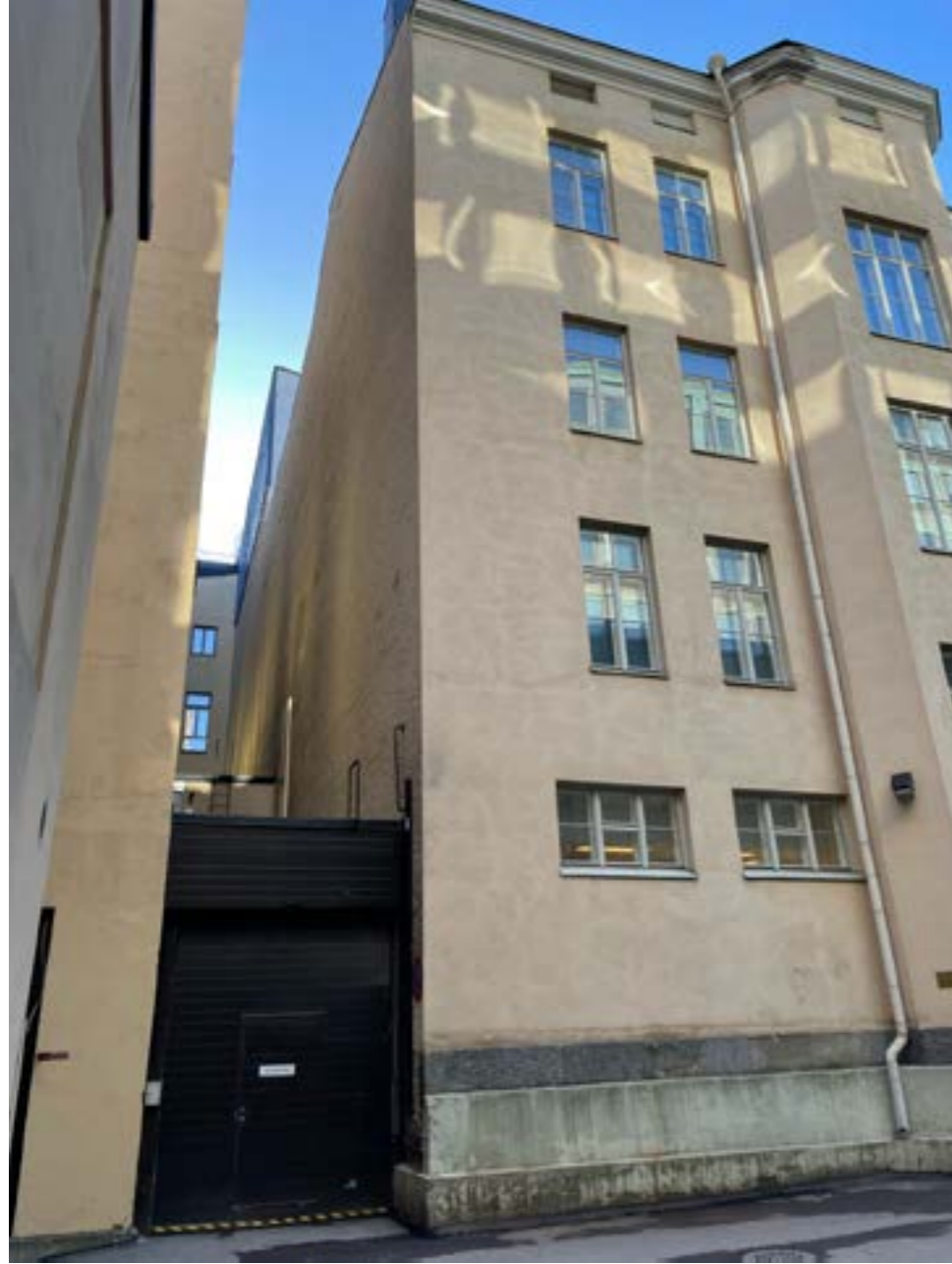
Kuva kiinteistöjen välillä olevasta huoltopihasta. Vasemmassa reunassa näkyy vie-reisen kiinteistön Pohjoisesplanadi 35:n musta huoltopihan oviseinä, jonka oikealla puolella on Pohjoisesplanadi 37:n takapihan ulkoseinää E-porrashuoneeseen asti.
