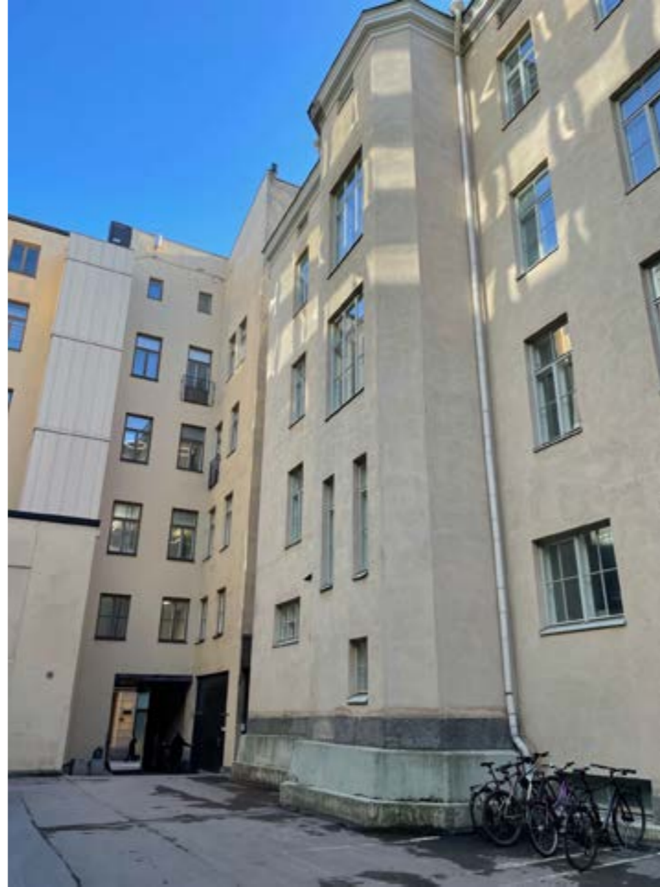
Takapihaa kuvattuna talon nurkalta kohti Vanhaa kauppakujaa. Oikealla Pohjoisesplanadi 37:n ulkoseinää, taustalla Pohjoisesplanadi 35:n julkisivua ja kulkuyhteys Vanhalle kauppakujalle.
