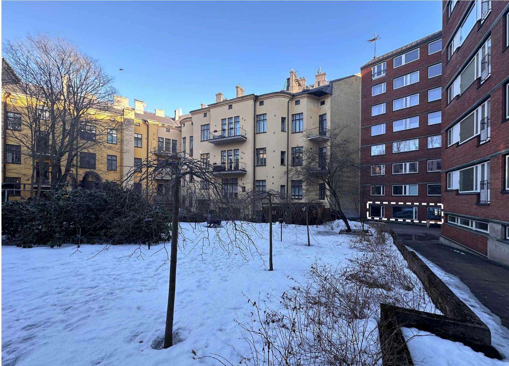
Näkymä sisäpihalta kohti etelää. Huoneisto 3 B18 ikkunat korostettu katkoviivalla.
