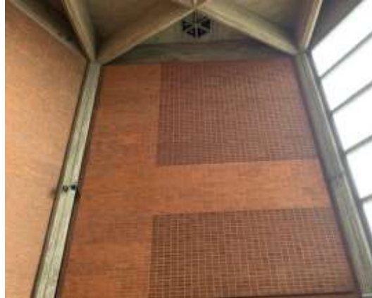
Kuva 98: Akustinen tiiliverhous
