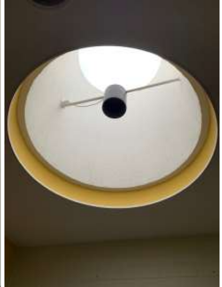
Kuva 119: Kattoikkuna toimistosiiven päässä
