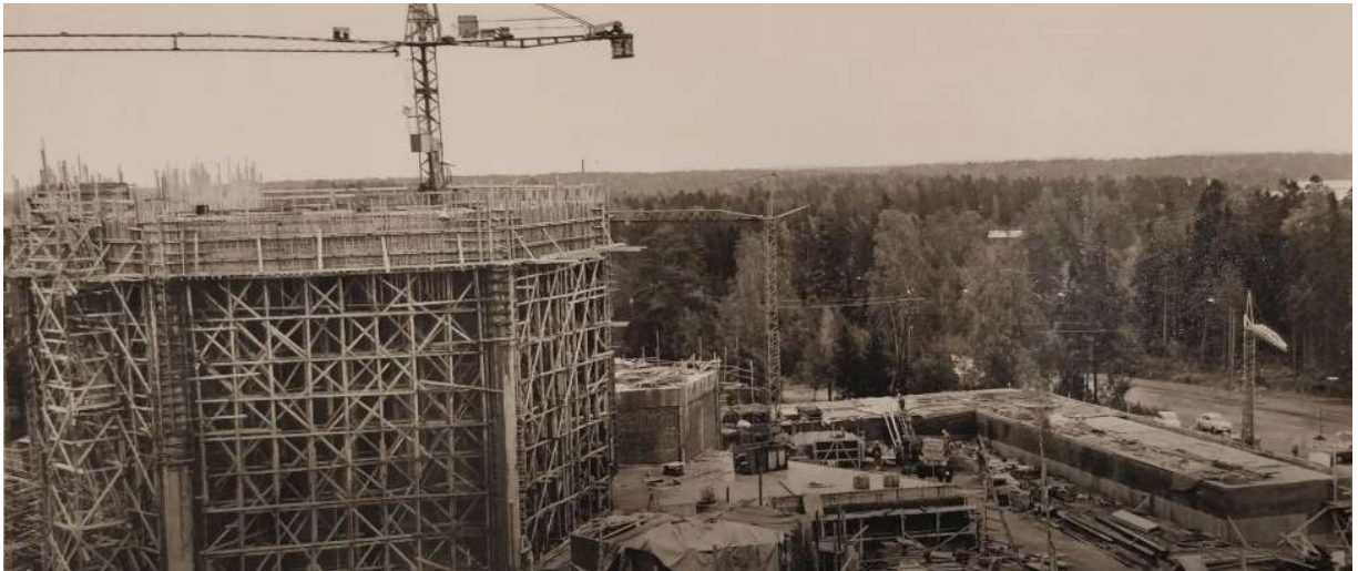
Kuva 27: Kirkko ja seurakuntasiipi rakenteilla
