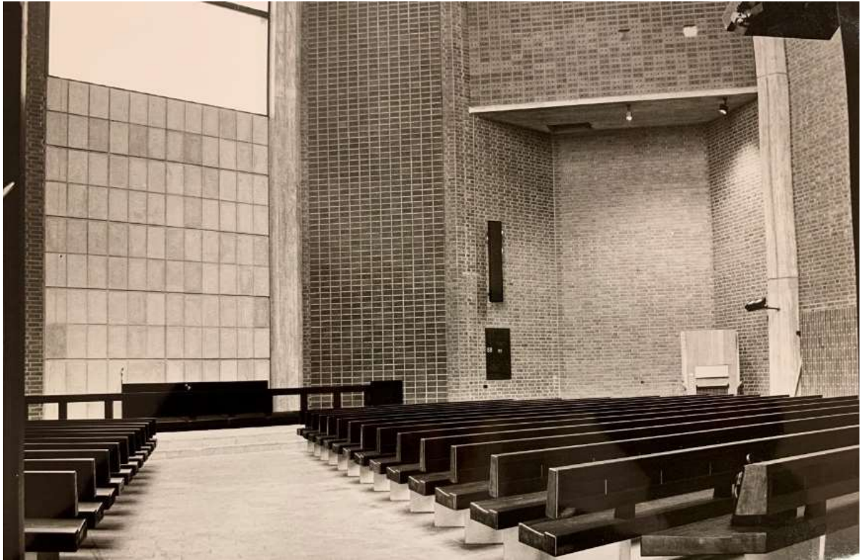
Kuva 56: Kirkkosalissa nähtävissä lattian kuusikulmaiset betonilaatat ja akustiset seinäverhoukset. Alkuperäisiä kiintokalusteita mm. penkkirivit ja alttari
