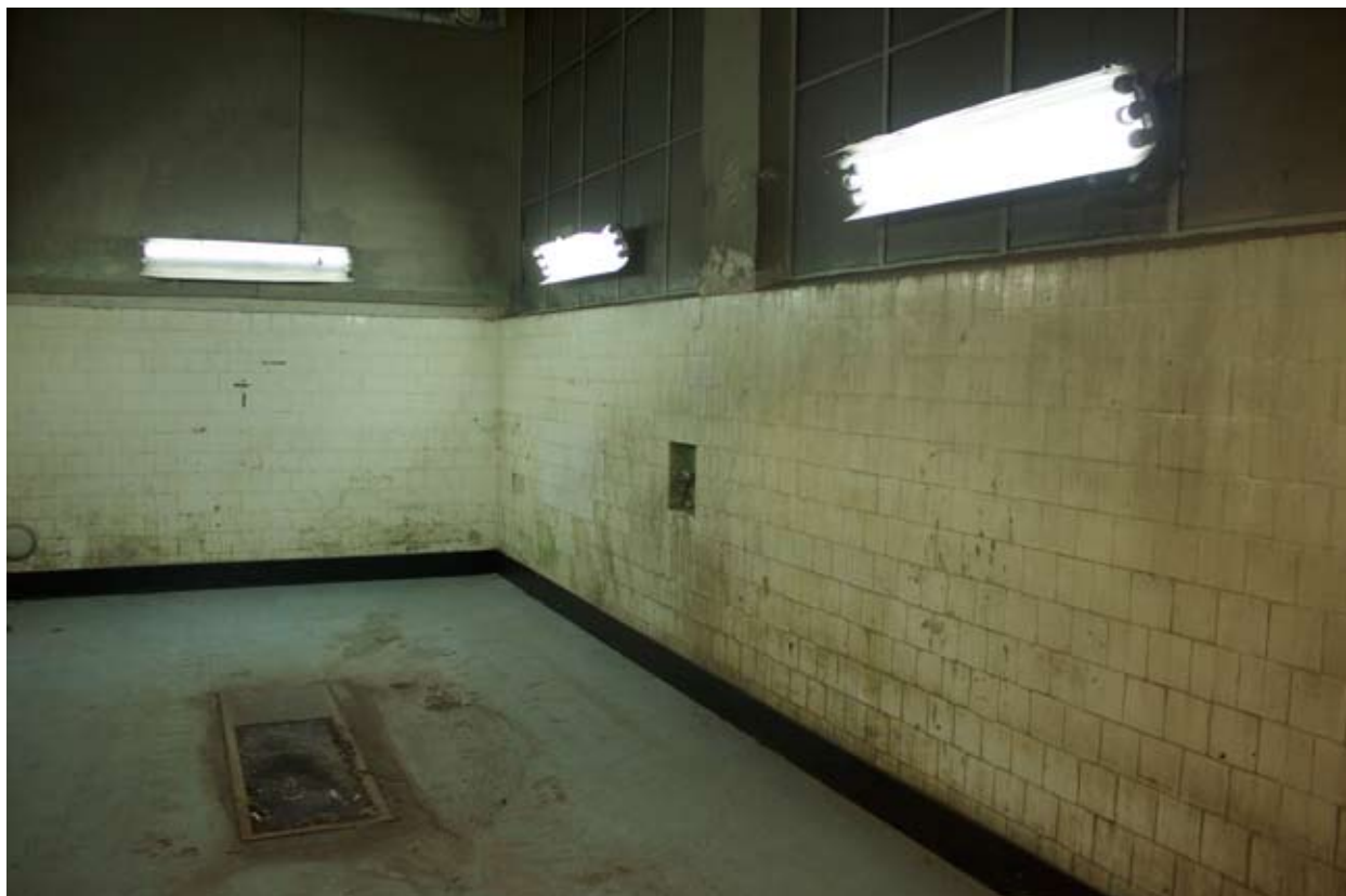
Kuvat 6.182-6.183 Näkymät autojen voitelutilaan "Smörjningsbox" 105.4
