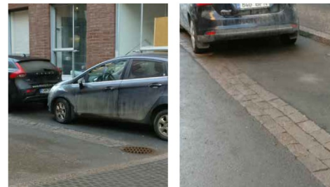
Reunarajauksen hyödyntäminen vedenkuljettamisessa, Jätkäsaari
