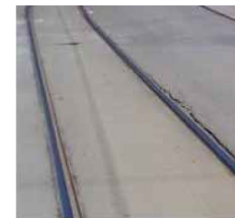
Asfaltti / Valettu betoni (raitiovaunun välit)
