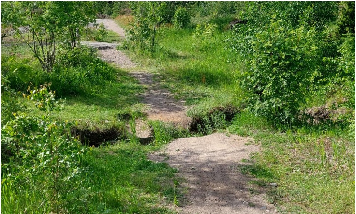
Kuva 31. Pääreitti ylittää alueen länsiosassa haudan vaarallisesti ja haudan reunat ovat kuluneet voimakkaasti. Paikalle rakennetaan kaivannon ylittävä silta.
