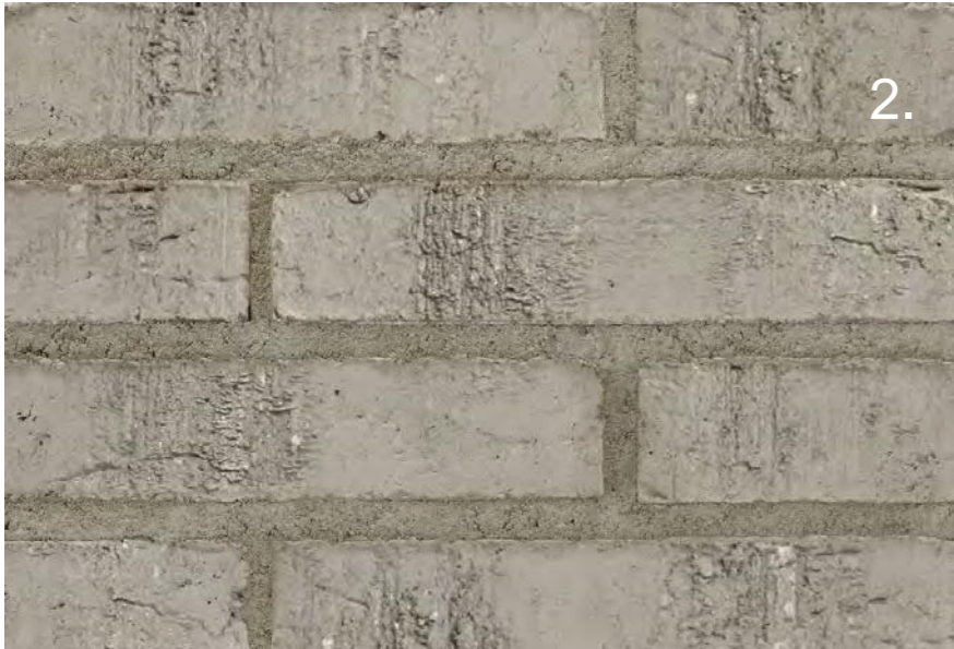
Paikalla muurattu tiili, vaaleanharmaa Luoto, pintastruktuuri Lusto (Tiileri Oy), saumaus harmaa Fescon Käki
