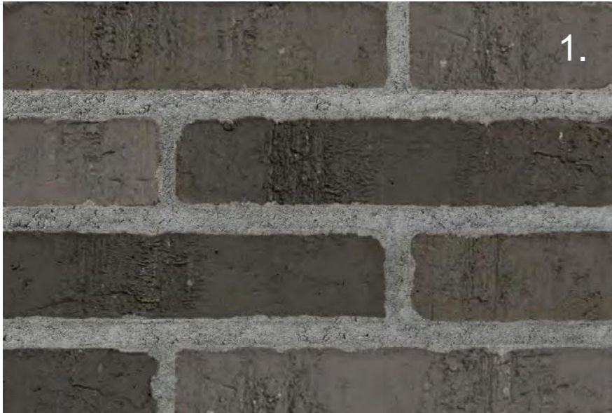
Paikalla muurattu tiili, tummanharmaa Laava, pintastruktuuri Lusto (Tiileri Oy), saumaus harmaa Fescon 74 haukka
