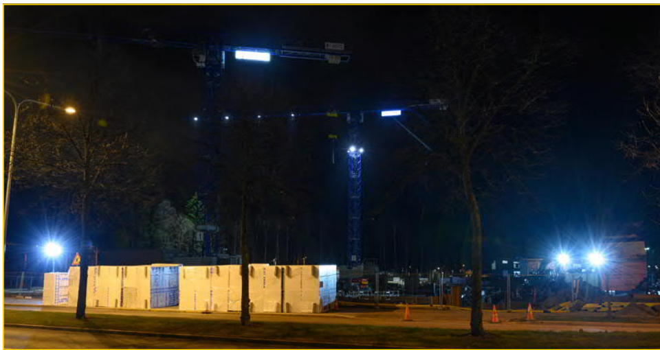
Rakennustyömaa Kauppakartanonkadulla, Itäkeskus
