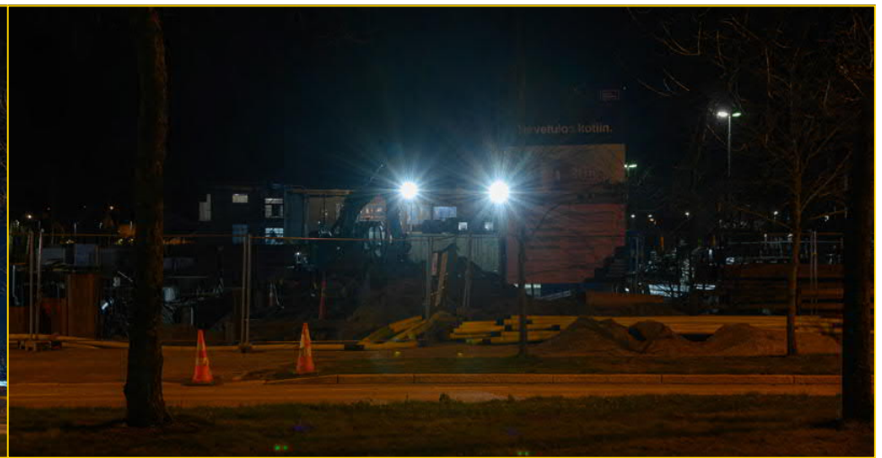
Rakennustyömaa Kauppakartanonkadulla, Itäkeskus
