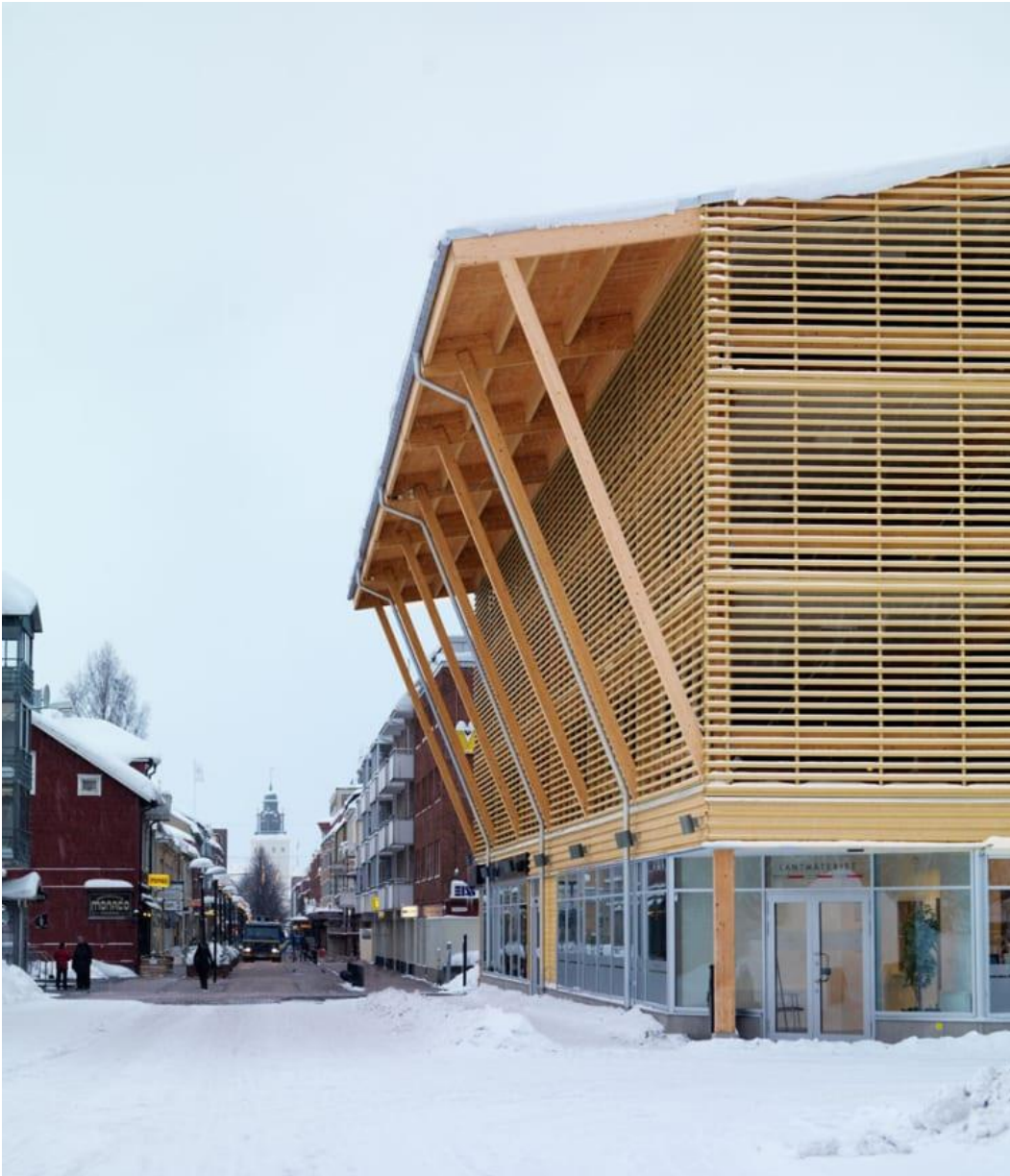
Kuva: Kv Ekorren, pysäköintitalo Skellefteåssa (AIX Arkitekter)
