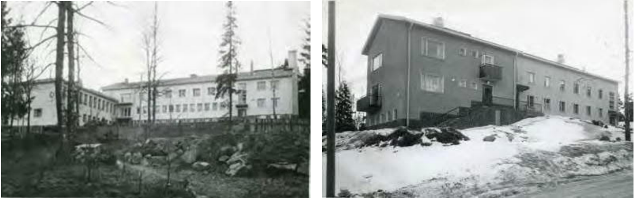
Teollisuuden työnjohto-opisto päärakennus A ja B talo, kuvattu ilmeisesti aikana jolloin B-taltoa rakennettiin. Teollisuuslehden valokuva-arkisto, kansio 14 (5–6). Elka.
