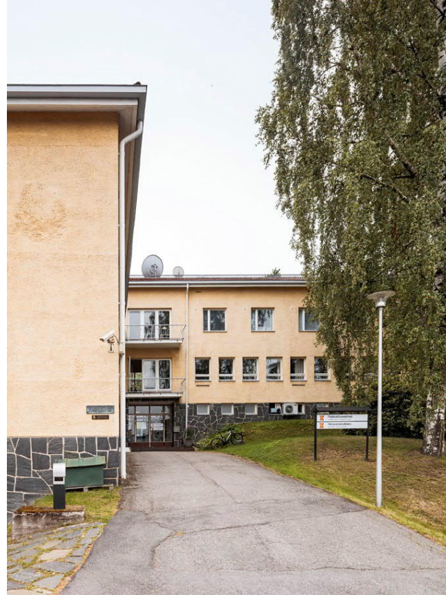
Suojeltavan päärakennuksen (RAK A) sisäänkäynti
