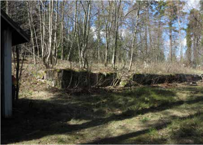
Kiviharkoista rakennettu tukimuri ylemmän puutarhaterassin reunalla. Vasemmalta leikkimökki.
