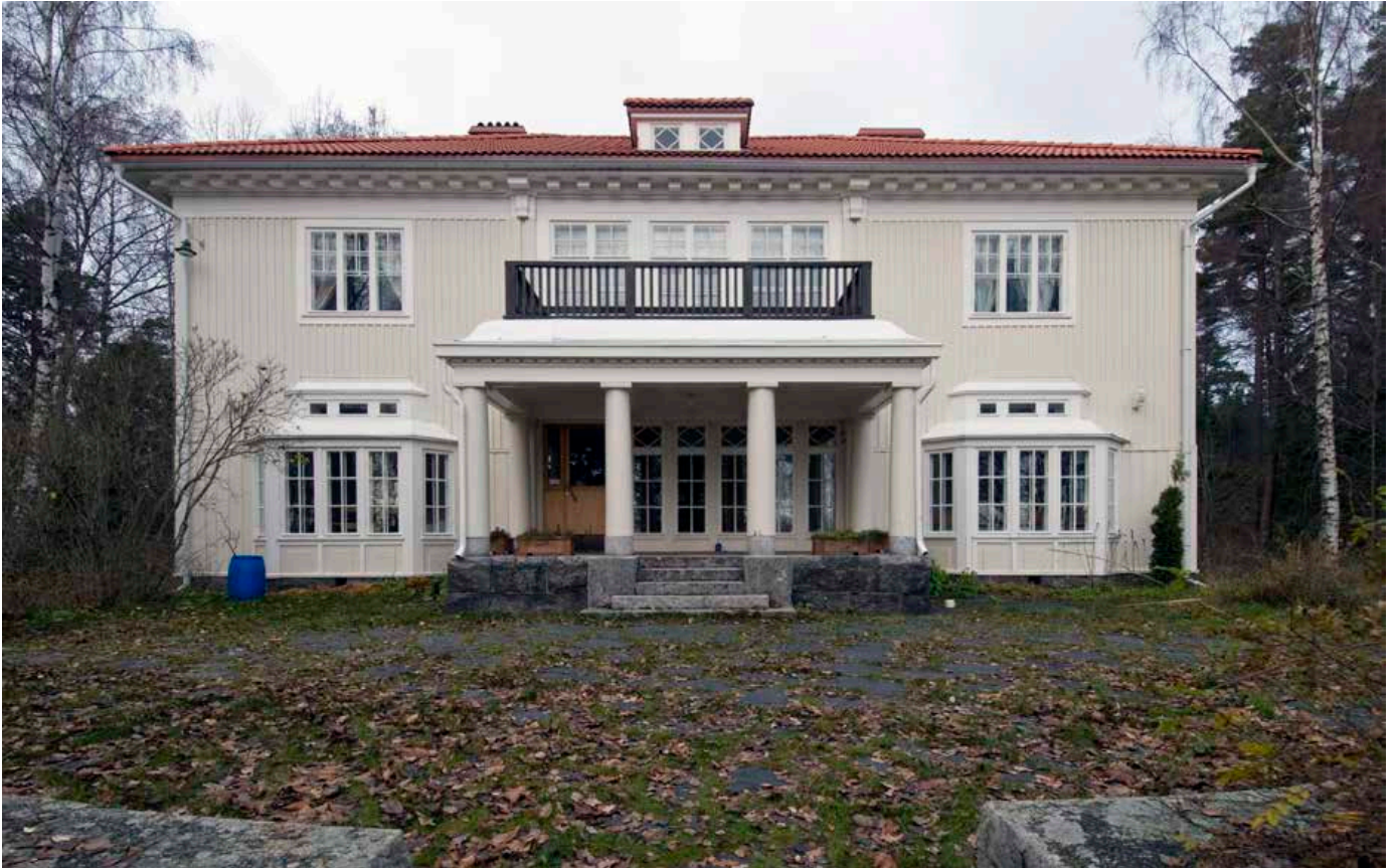
Muutoksista huolimatta päärakennus on säilyttänyt klassistisen ulkoasuensa. Kari Hakli
