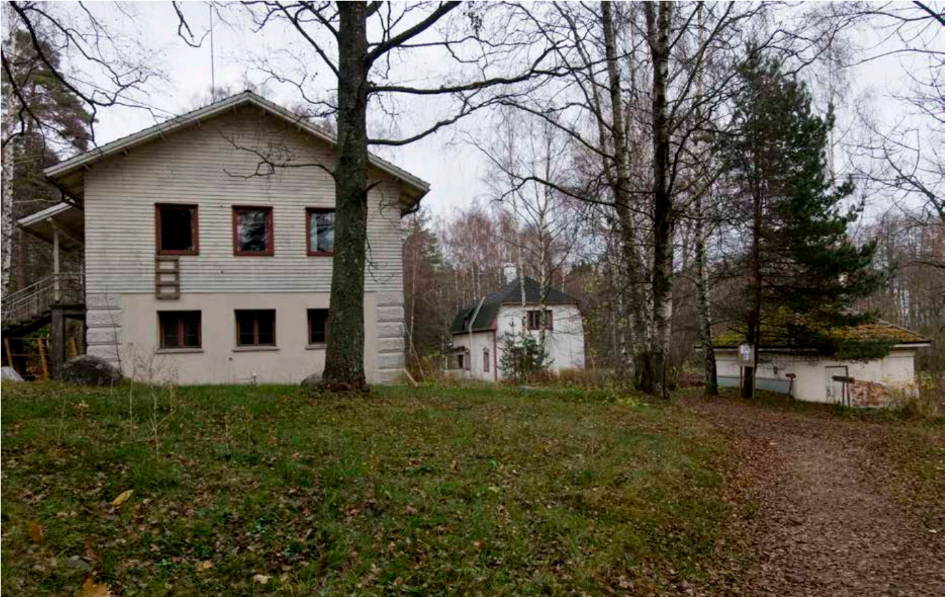
Navetta / majoitusrakennus. Kari Hakli 2011
