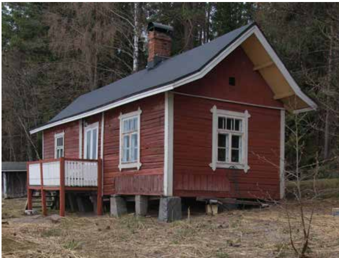
Hirsisaunaan liittyy rankarakenteinen laajennus, jota on käytetty työpajana.
