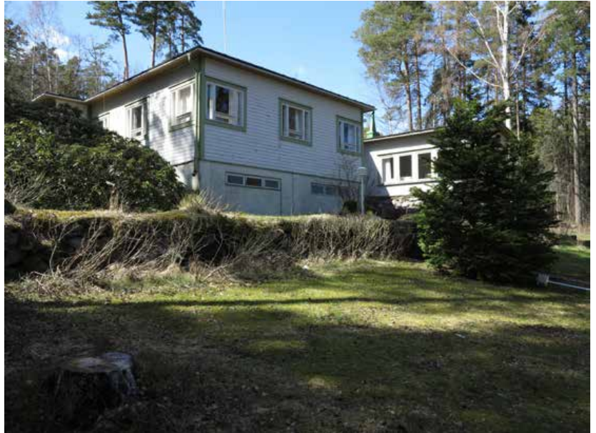
Huvilalle on muodostettu yksityinen reviiiri terasien avulla.
