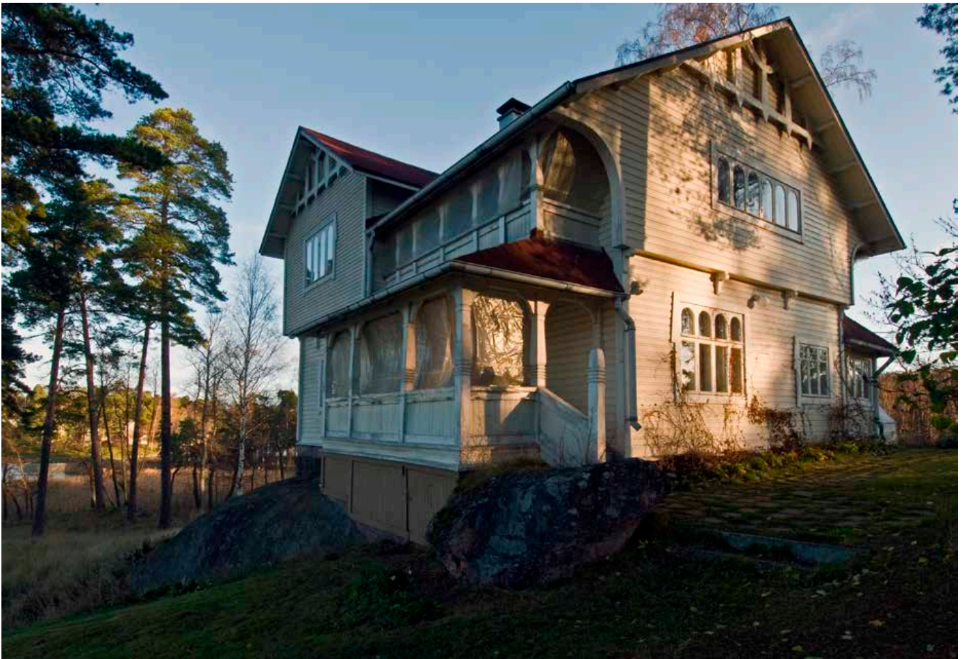
Nykyinen julkisivuvuoraus on 1900-luvun alusta. Kuva Kari Hakli 2011
