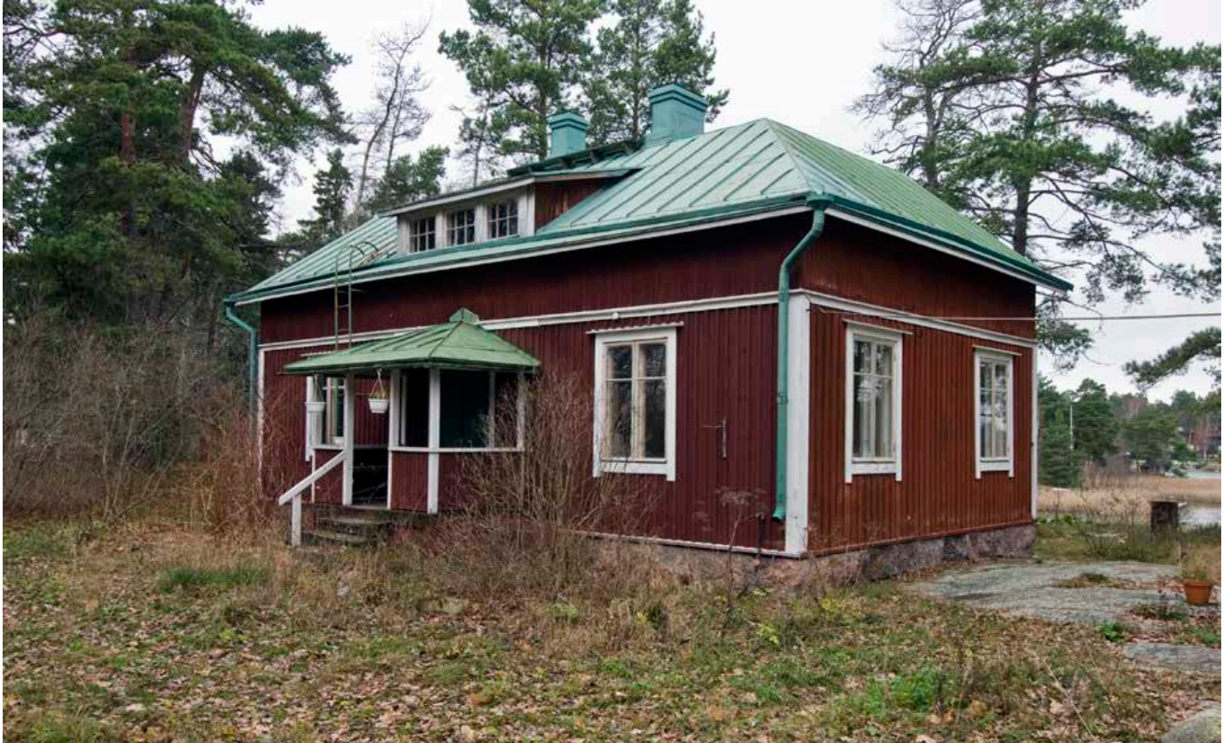
Näkymä kaakosta. Sisäänkäynti on eteläsivulla. Kari Hakli 2011
