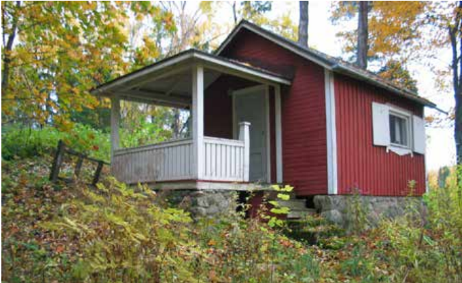
Kuistin kaide on uusittu soveltaen 1900-luvun alussa suosittua, pystysuuntaisista laudoista tehtyä mallia.
