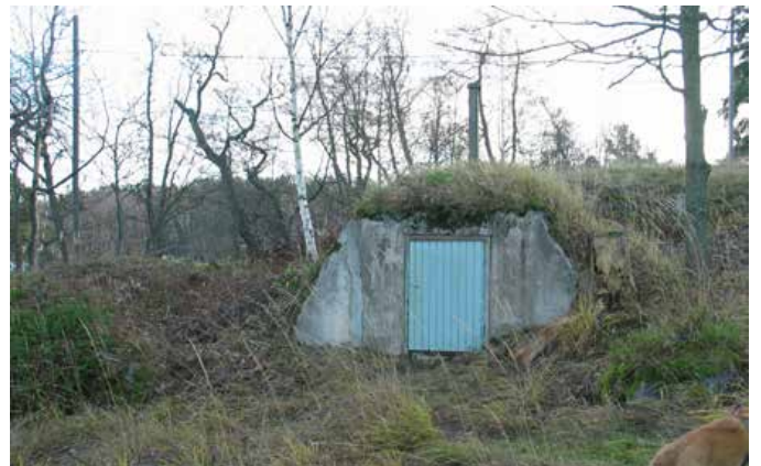
Kumpareeseen kätkeytn maakellarin sisäänkäyntisivun muurit on valettu betonista.
