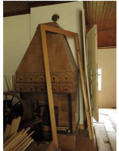
Eiel Saarisen piirustusten mukaan valmistettu kaakeliuuni. Korjaustyön aikainen valokuva.
