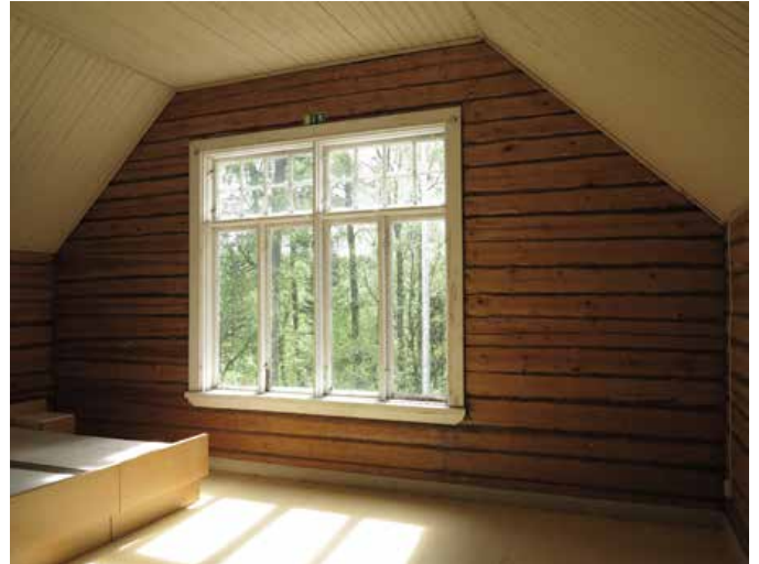
Toisen kerroksen päämakuuhuone leveine ikkunoineen. Hirsiseinät on paljastettu poistamalla pinkopahvit ja tapetit.
