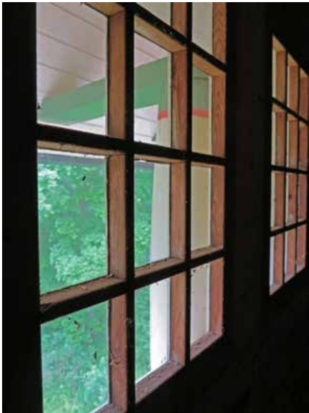
Ullakolla säilynyt alkuperäinen puuikkuna.
