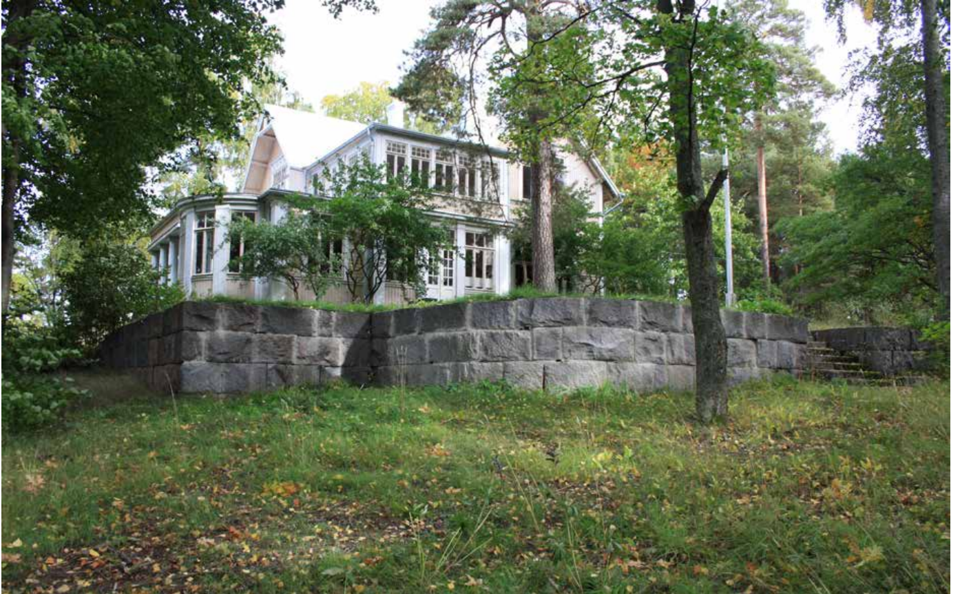
Huvilan piha-alueen korkea terassimuuri on rakennettu isokokoisista kivihaikoista.
