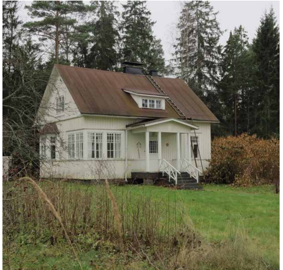
Kauempana rannasta sijaitseva, tien suuntainen harjakattoinen ja puolitoistakerroksinen asuinrakennus. Rungon sisään rakennettu lasiveranta on aikakaudelle tyypillinen piirre Vartiosaassa.
