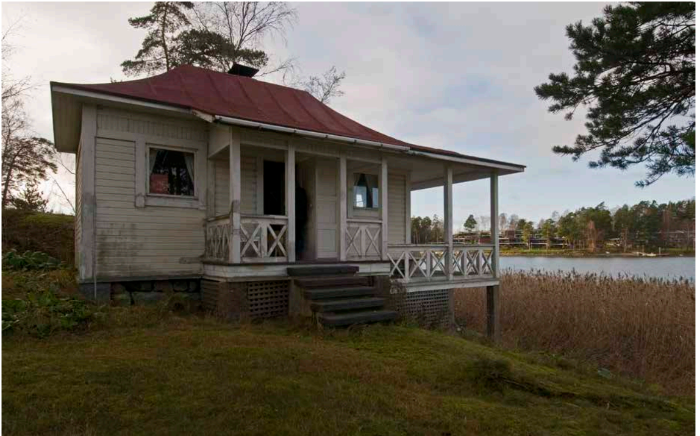
Saunan hirrestä rakennettua ydintä täydentävät avoimet kuistit kahdella sivulla.
