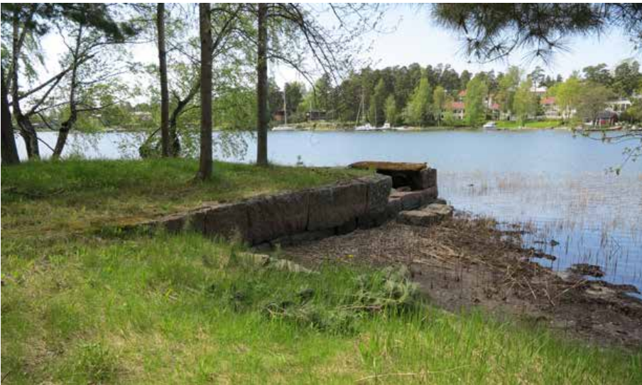
Uima-altaan suora reunamuuri on säilynyt niemen luoteisrannalla.
