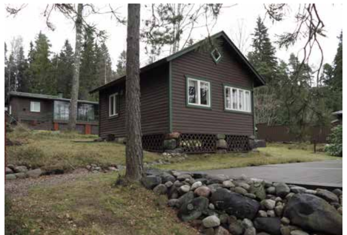
Voutila. Puutalo Oy:n tyyppipiirustusten mukaan 1960 rakennettu kesämökki ja samaa muotokieltä edustava sauna.
