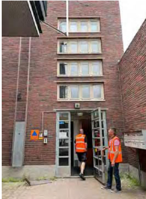
Kuva 41. Käynti pohjoispuolen alkuperäiseen porrashuoneeseen.
