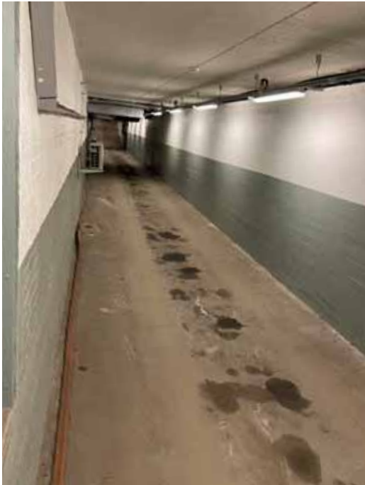
Kuva 81. Kellarissa lännen puoleisella seinustalla kulkeva koko rakennuksen pituudelta oleva huoltoajotunneli.
