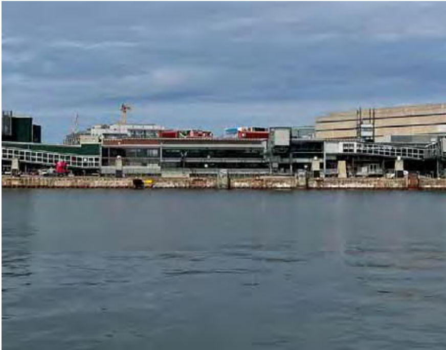
Kuva 47. Julkisivu itään (merelle/Hernesaaren suuntaan) on vahvasti maykustajasiltojen peitossa.
