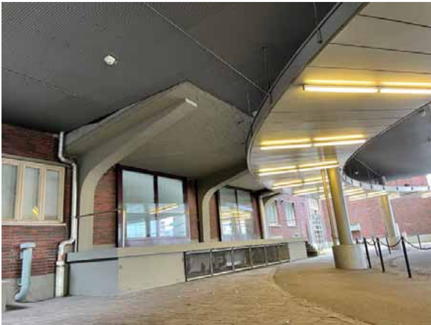
Kuva 43. Pohjoispuolen päädyssä oleva katos.
