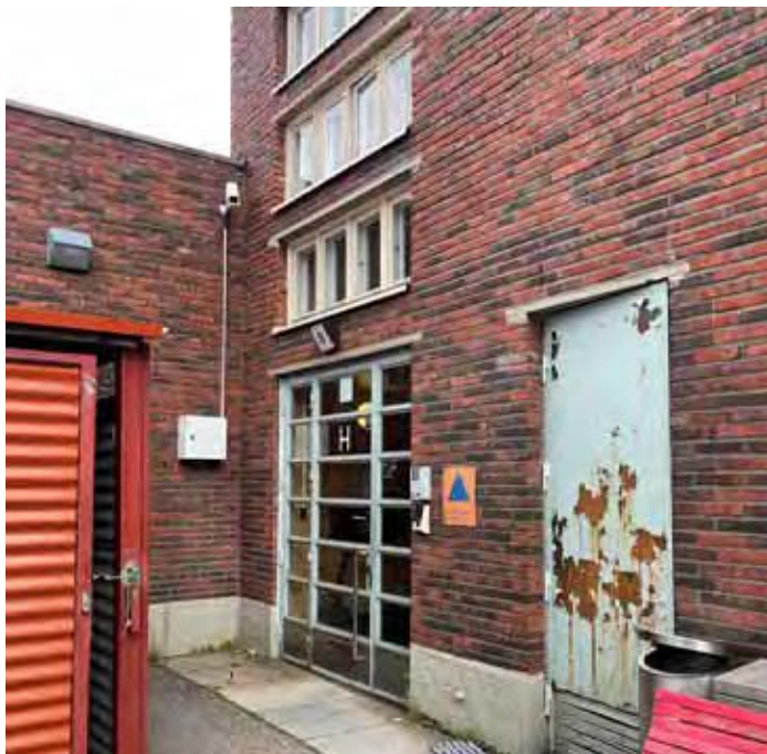
Kuva 63. Sisäänkäynti eteläjulkisivussa olevaan porrashuoneeseen.
