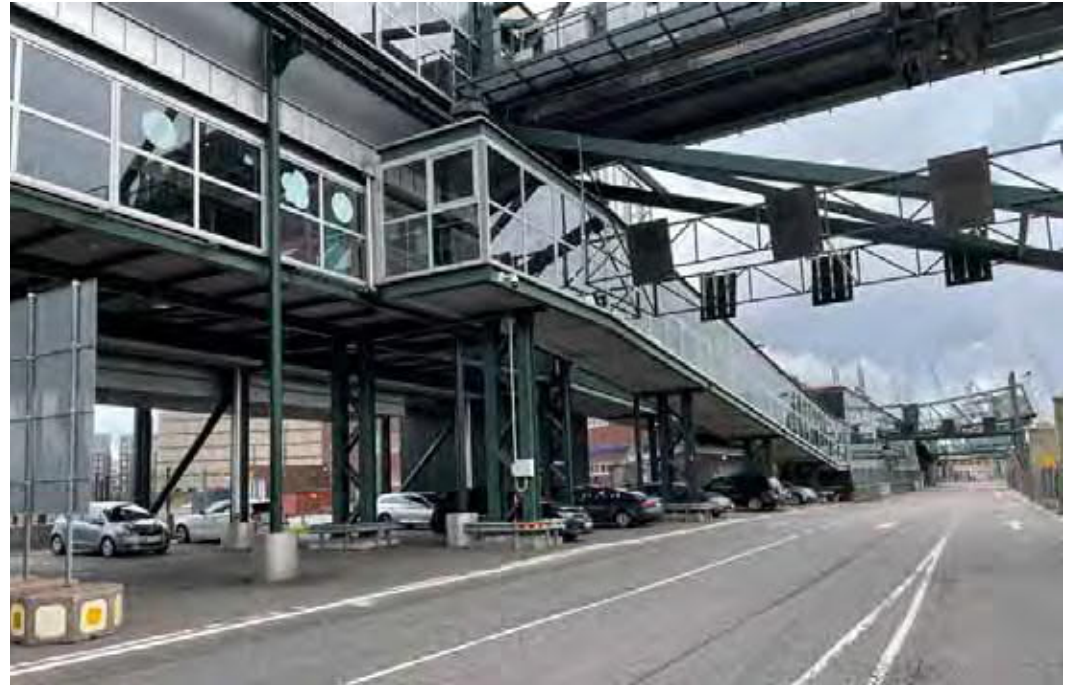
Kuva 48. Julkisivu itään ja etelään laiturin suunnasta katsottaessa.
