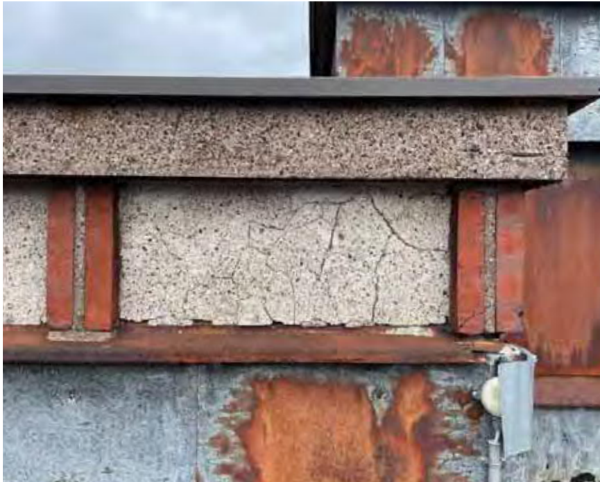
Kuva 52. Yksityiskohta pystytiilikoristeaiheesta vesikatolla
