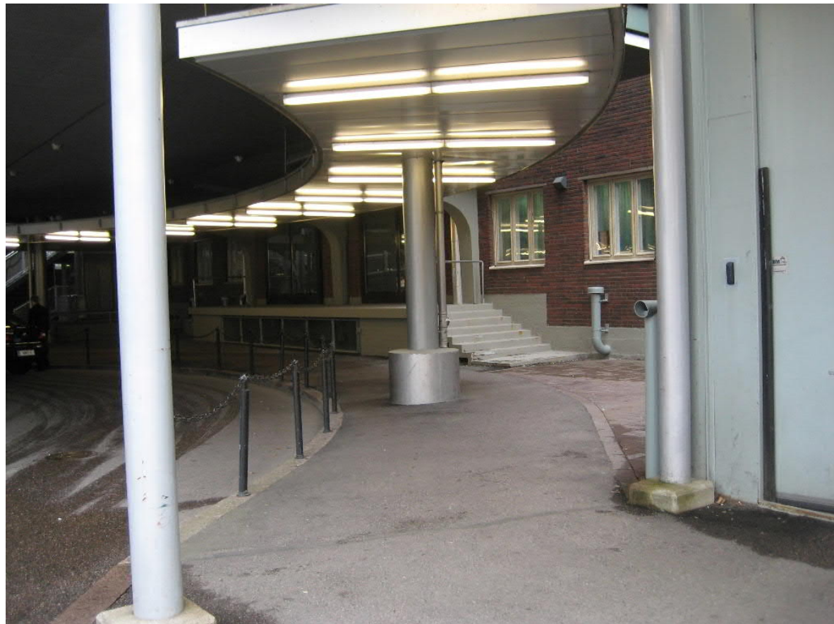
Kuvaliite suojelukohteista Länsisataman terminaali 1 Asemakaavan muutos
