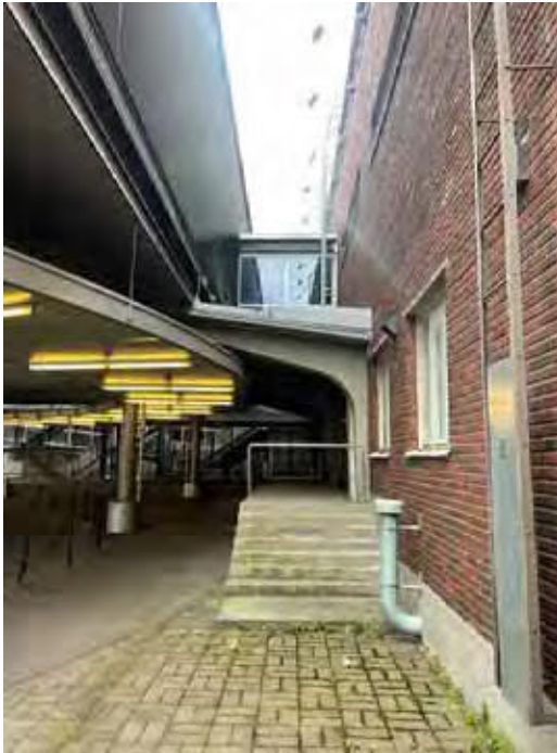
Kuva 40. Pohjoisjulkisivun ja laajennuksen väliin jätetty alkuperäinen katosrakennelma.
