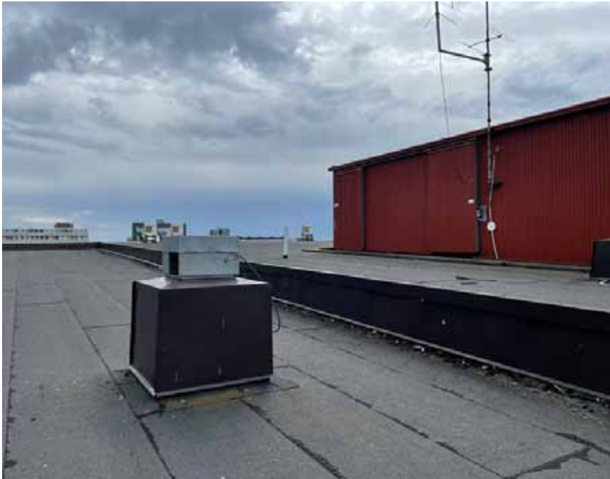
Kuva 49. Vesikaton korotusosan korkoero etualalla, taustalla uudet iv-konehuoneet (punaisia).
