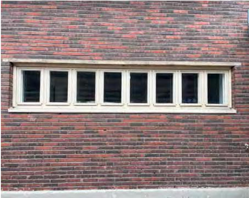
Kuva 38. Länsijulkisivun eheää tiilipintaa ja alkuperäinen ikkunarivistö.
