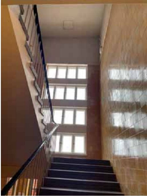
Kuva 59. Porrashuoneissa on säilynyt alkuperäiset ikkunat ja heloitukset.
