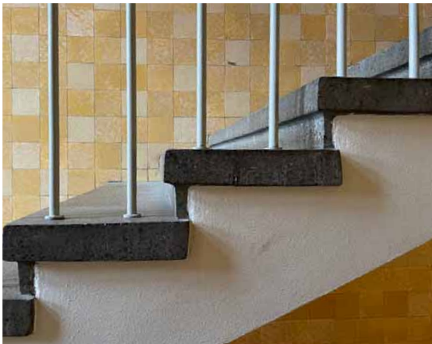
Kuva 57. Porrasaskelmat, taustalla laattaseinää näkyvissä.
