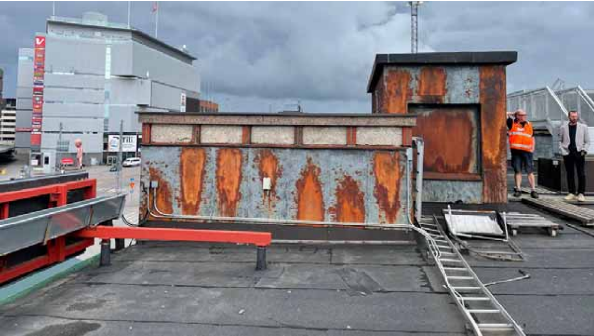
Kuva 54. Porrastornin detailjiikka kauempaa, taustalla olevasta oikeanpuoleisesta korkeammasta tornirakennelmasta on sisäkulkuyhteys vesikatolle.
