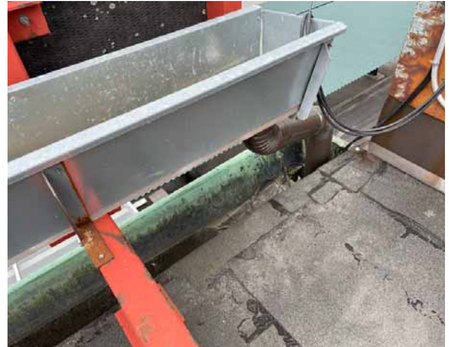
Kuva 55. Alkuperäiset vesikourut on säilytetty julkisivussa, mutta päälle lisätty nykyaikaisemmat ei-kupariset vedenpoistojärjestelmät.
