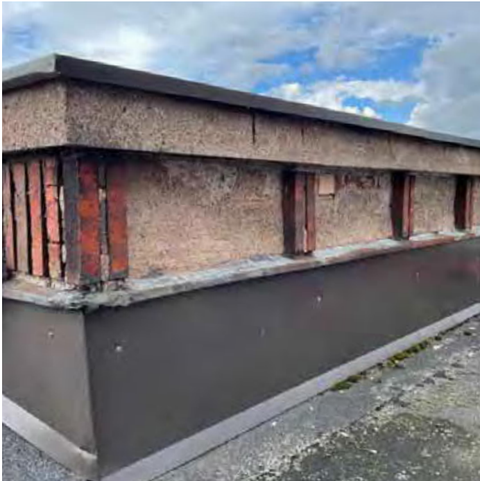
Kuva 51. Yksityiskohta julkisivun ja korkeampien osien (porrastornit) yläreunaa kiertävästä eaiheesta.
