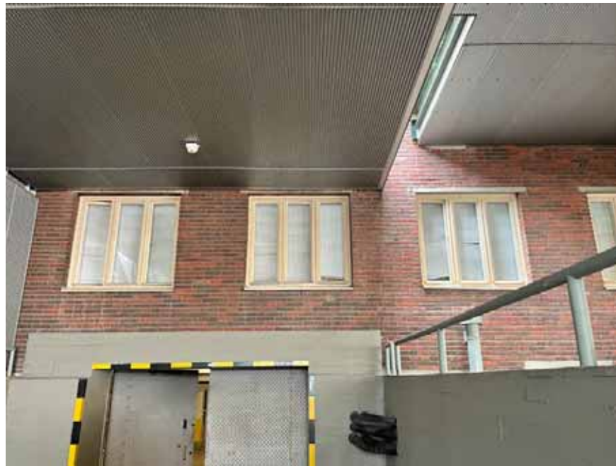
Kuva 44. Pohjoispuolen päädyn katoksen peittoon jäävää julkisivua.
