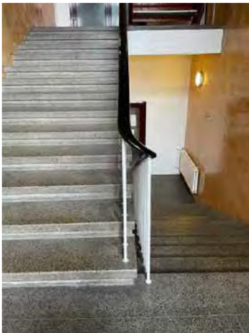
Kuva 56. Yksityiskohtia pohjoispäädyn alkuperäisestä porrashuoneesta
