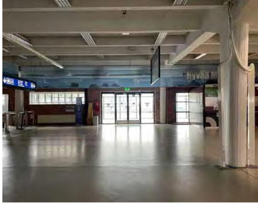
Kuva 75. Matkustajaisilloille lisätyt kulkuyhteydet tuovat valoa tilaan. Oikealla silmämääräisesti kallistunut pilari.
