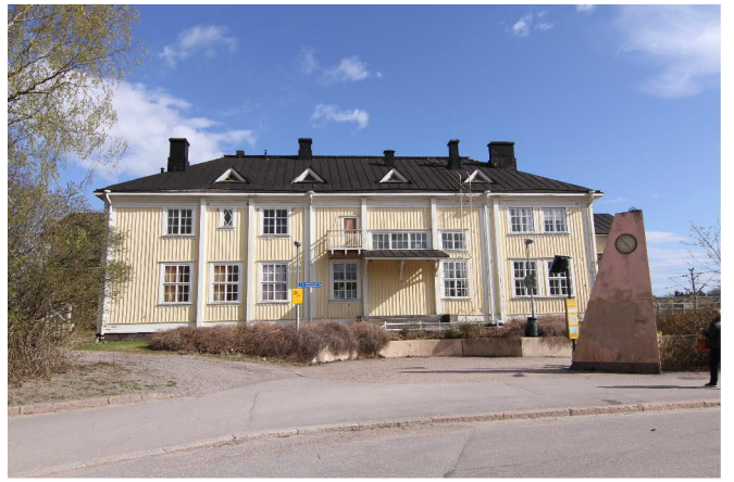
Vanha asemarakennus (säilytetään)
