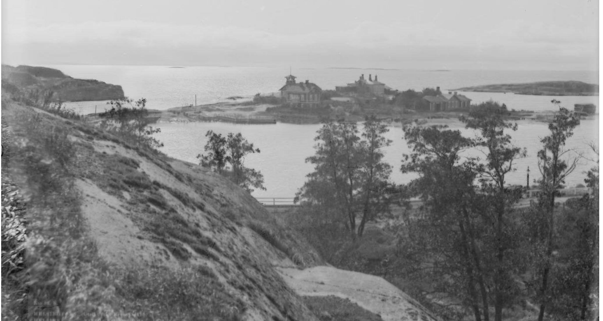
Uunisaari Kaivopuistosta kuvattuna vuonna 1890. Useimmat viereisen sivun asemapiirroksessa (1882) esitetyt rakennukset näkyvät kuvassa, ainoastaan liiteri jää puuston peittoon. Vasemmalta oikealle: vanhempi asuintalo uusine torneineen, sen edessä uusi asuinrakennus,
