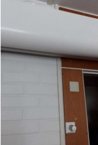
Saneeraamattomien tilojen ilmastointipalkit ja huonekohtaiset termostaatit TA
