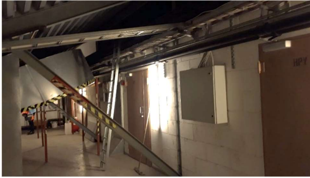
Ullakon sivutila, jossa vinot kattoa tukevat teräsrakenteet
