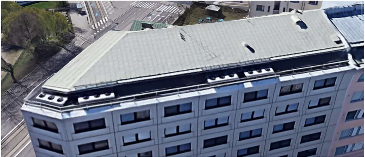
Rakennuksen vesikatto (kuva Google Earth)
