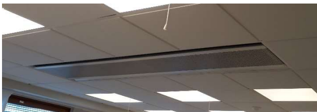
Saneerattujen tilojen alakatossa olevat ilmastointipalkit sekä katonrajassa olevat yksikkösäätimet
