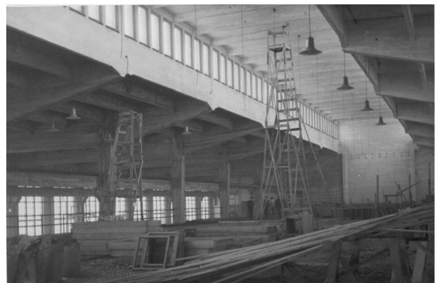
Kuva 3.13 Tehdashallin kattolyhty rakennustöiden loppuvaiheessa. MOBA.
