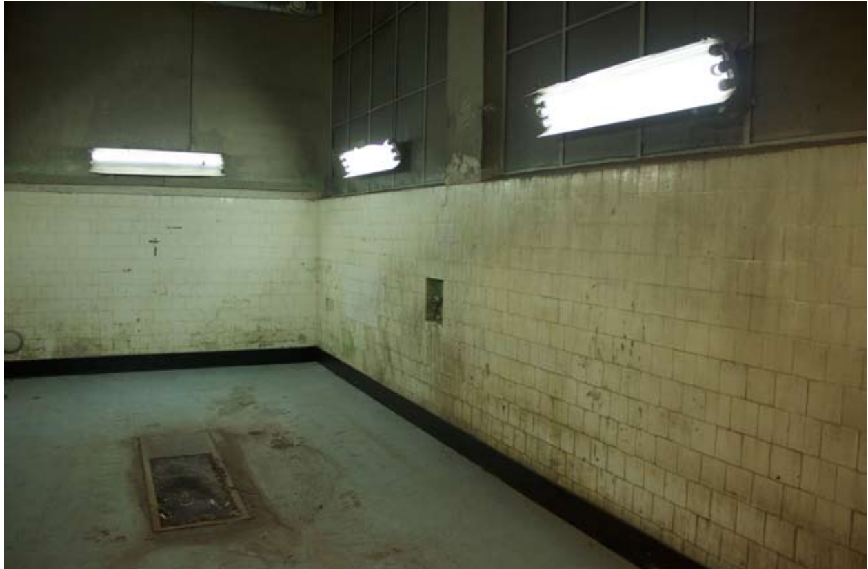
Kuvat 6.182-6.183 Näkymät autojen voitelutilaan "Smörjningsbox" 105.4
