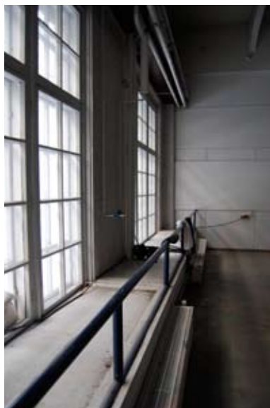
Kuvat 6.234-6.235 (ylärivi) Näkymä tilaan 221.1. Ikkunaseinän ja väli- pohjan liittyminen toisiinsa. Kuvat 6.236-6.237 Yleisnäkö ja yksityiskohta tilasta 221.2
