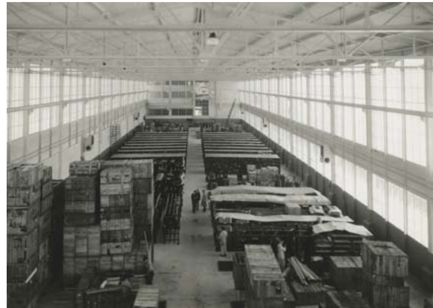
Kuva 1.3 Tukholman Frihamin Fordin tehtaan sisätila vuonna 1930. Lähde http://commons.wikimedia.org/wiki/Category:Fordbyggnaden_Stockholms_frihamn
