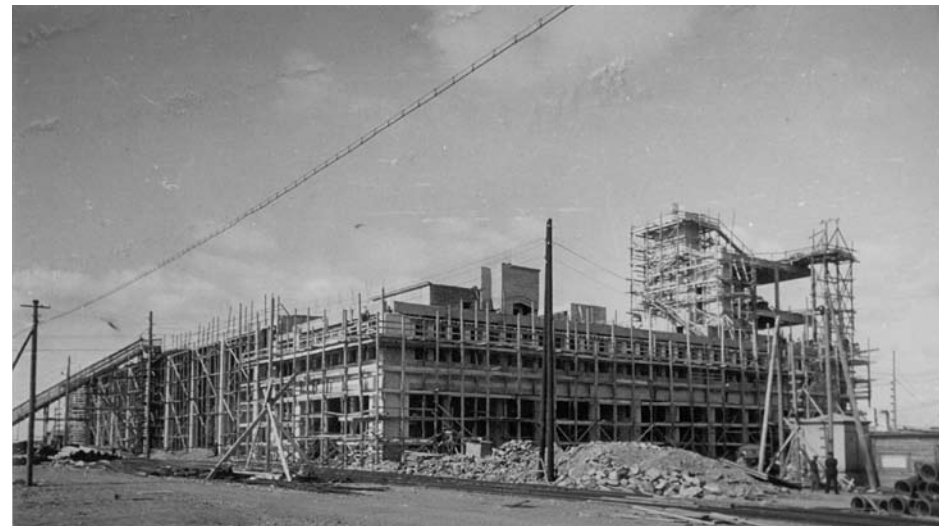
Kuva 3.8 Tehtaan työmaa. Torni nousee. FORD
