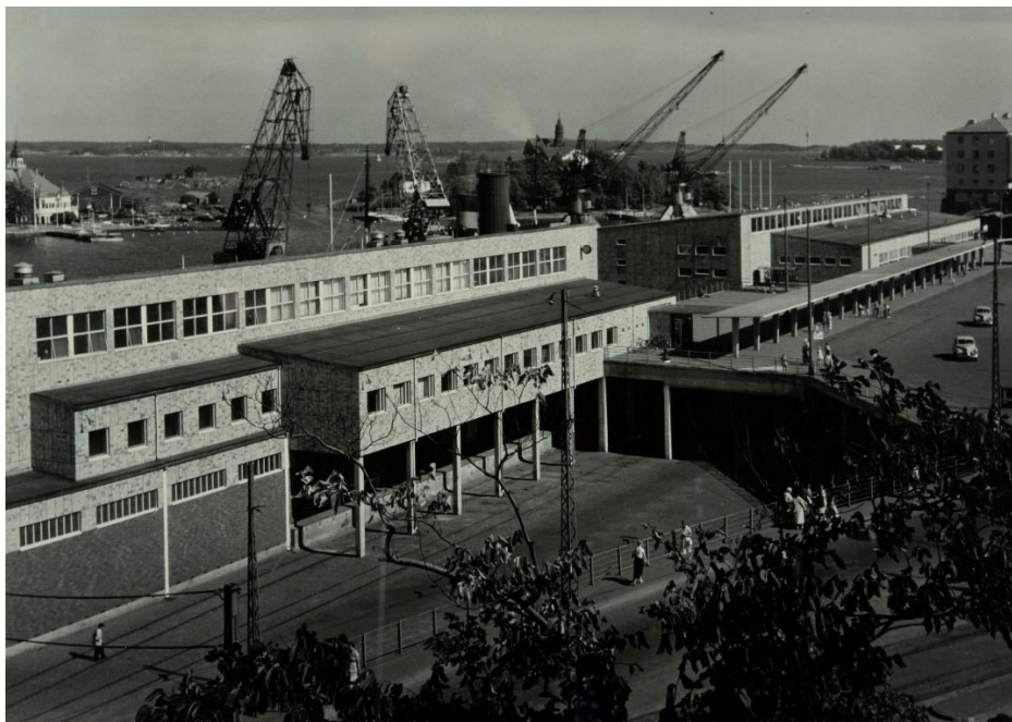
Kuva: Satamatalo ja Olympiaterminaali, 1950-luku, Helge Heinonen (HKM)
