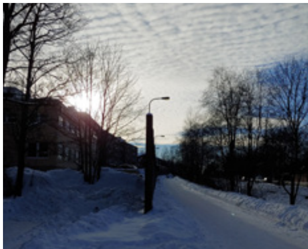
Itäväylän meluseinää Vehkalahdentien ja Itäväylän risteyksestä länteen.
