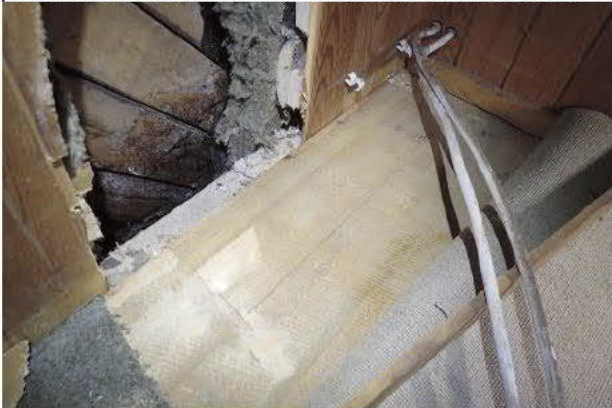
Kuva 25. Kokolattiamattoa avattu, alla ponttilaudoitus.
