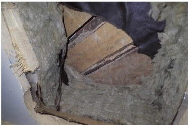
Kuva 11. Villaeristeiden takana on tervapaperi ja vinolaudoitus.
