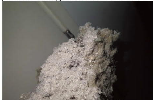
Kuva 41. Kivivillan päällä on puhallusvillaa.
