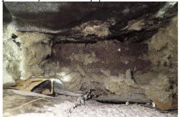
Kuva 12. Kuvaa alaspäin, alajuoksupuun on aistinvaraisesti arvioituna vaurioitunut.
