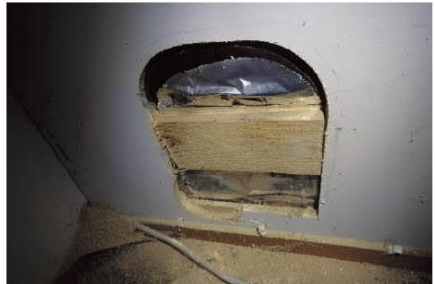
Kuva 10. Sisäverhouslevyn takana on lautakoolaus ja alumiinipintainen tervapaperi.
