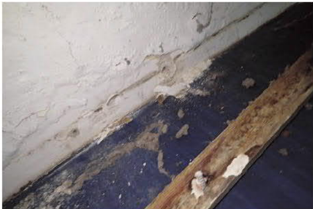
Kuva 33. Jalkalista irrotettu.
