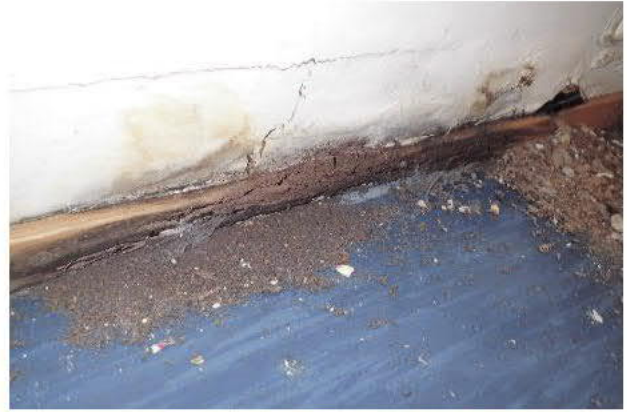
Kuva 28. Lastulevy on hyvin pehmeää, jalkalista on osin lahonnut pois.
