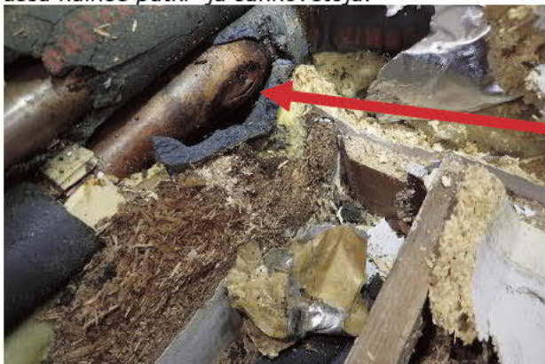
Kuva 46. Vuotokohta kupariputkessa.
