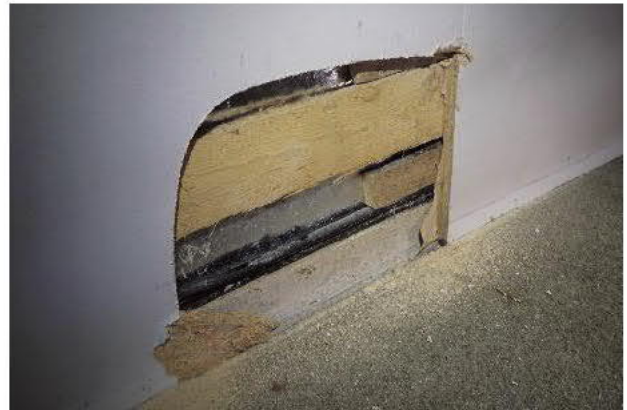
Kuva 16. Rakenne on vastaa kuin avauksessa RA1.
