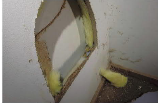
Kuva 43. Sisäpinnassa on 50 mm lisäeristys.
