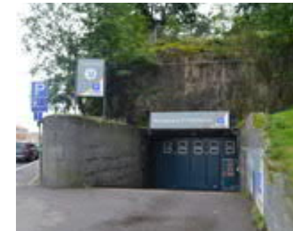
Kuva 27. Nykyisen sisäänkäynnin laajentaminen vaatii louhimista, muttei vaikuta olennaisesti maisemaan kohdistuessaan olemassaolevaan suuaukkoon ja sen liittymään katuverkkoon.
