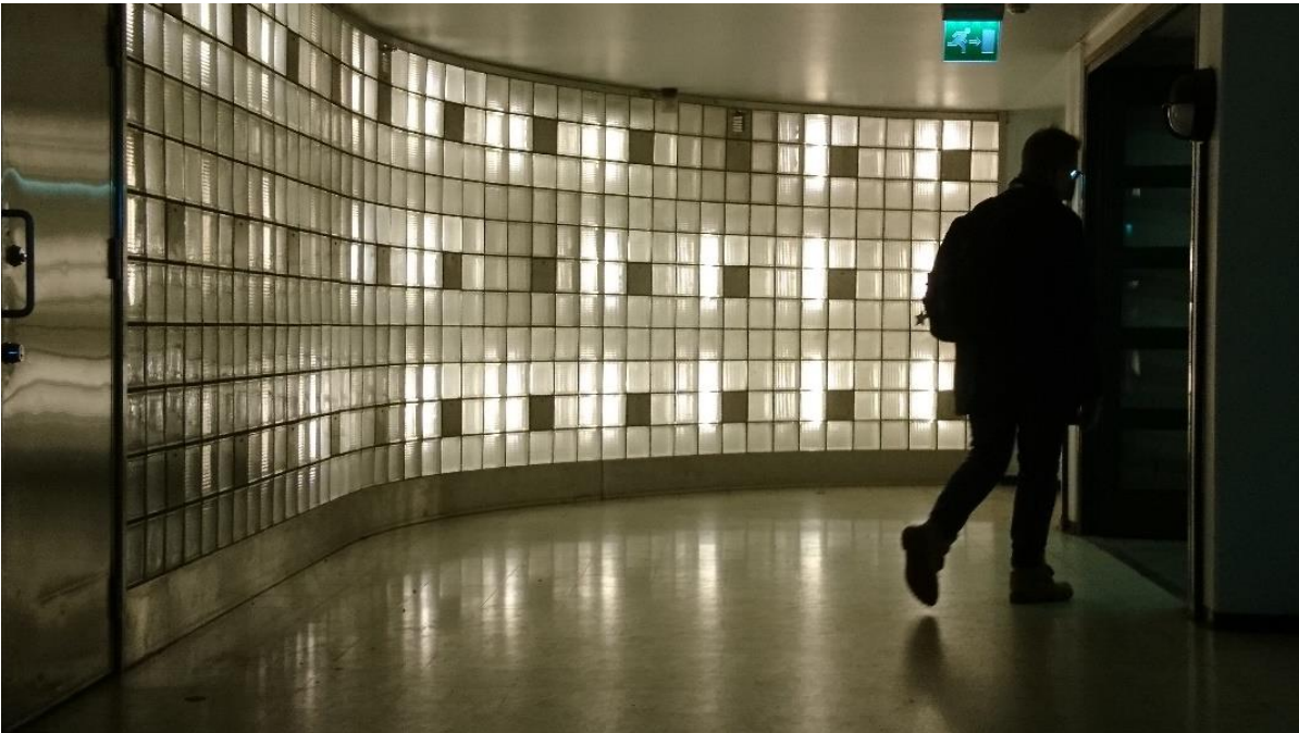
Kuva 39. Poikkeus ydinkeskustan tunnelien valaistuksen persoonattomasta yleisilmeestä on lasitiiliratkaisu Yliopiston metroaseman sivu-uloskäynnillä.
