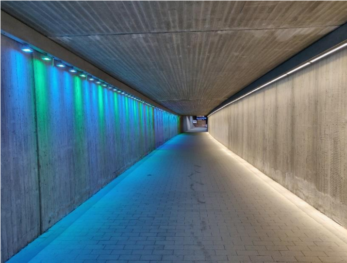
Kuva 40. Pasilan asemalta autojuna-asemalle ja Hartwall-areenalle johtavalla kevyen liikenteen väylällä on onnistuttu valaistuksen avulla keventämään pitkän betonitunnelin ilmettä.
