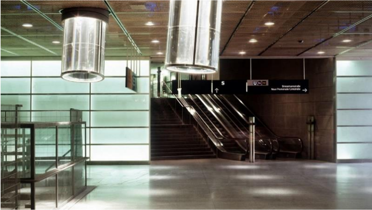
Kuva 42. Kolme "valoputkea" taivattavat ja tuovat luonnonvaloa Potsdamer Platzin maanalaiselle asemalle. Kuvälähde: https://www.krapfag.ch/en/reference-projects/metal-construction/light-pipes-berlin-potsdamer-platz/
