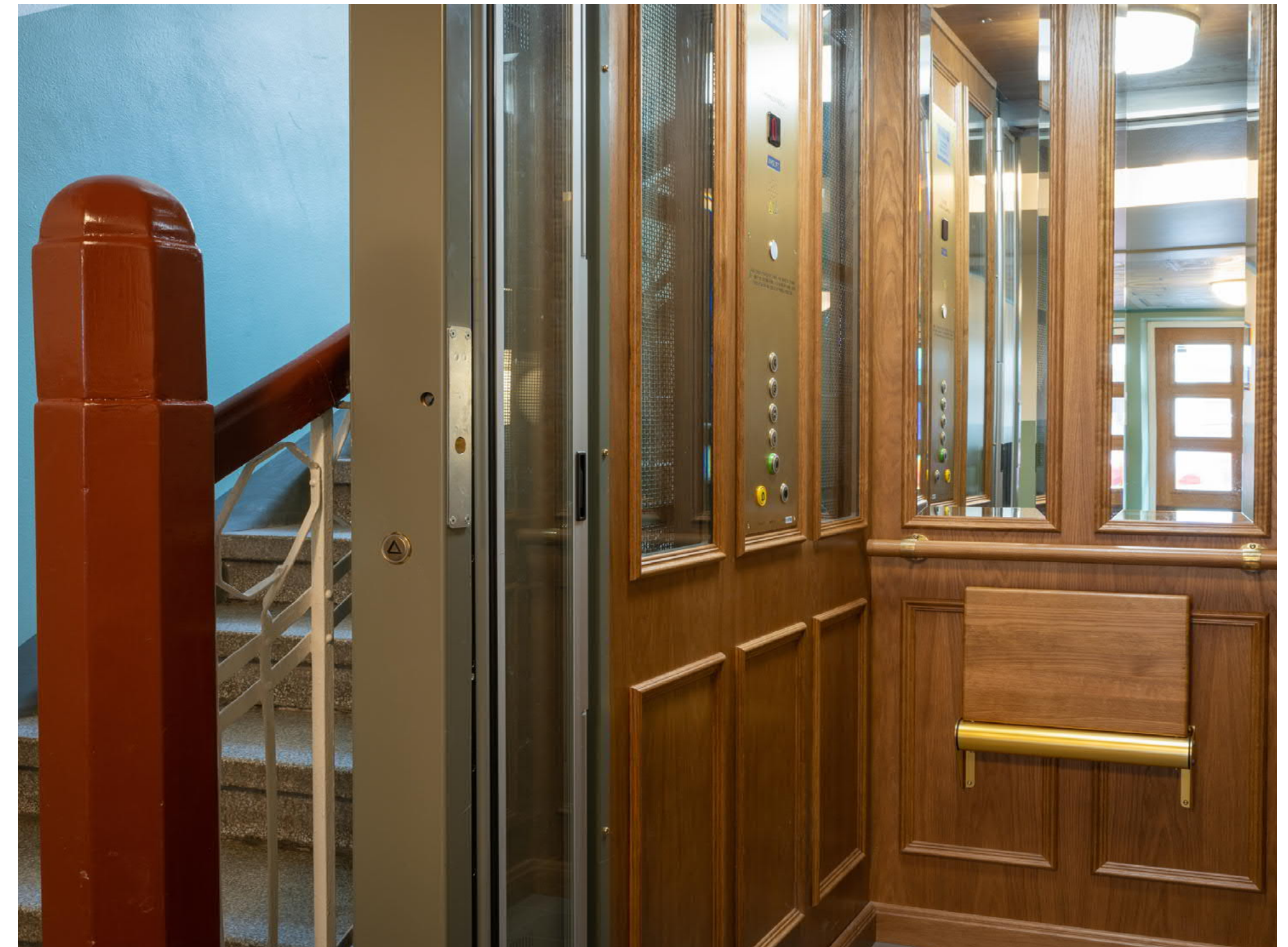
Jälkiasennushissi Ullanlinnassa 2021. Kuva: Simo Merilä
