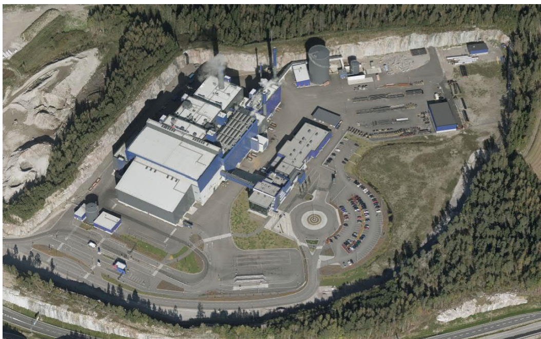
Kuva 6-11. Jätevoimala sijaitsee kallioon louhitussa syvänteessä (Viistoilmakuva: Vantaan karttapalvelu).
