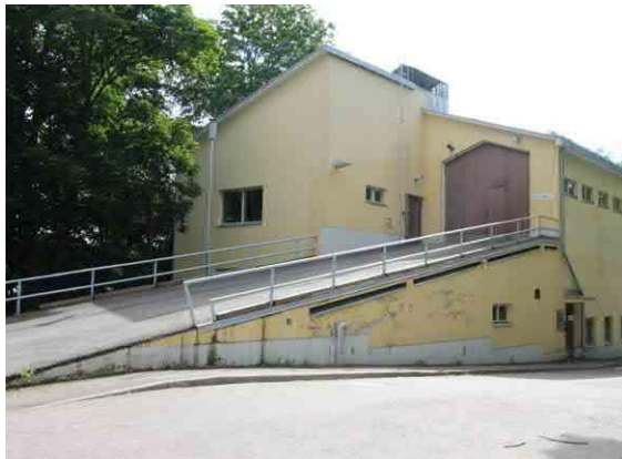
Laakson sairaalan vuonna 1956 valmistunut lämpökeskusrakennus.
