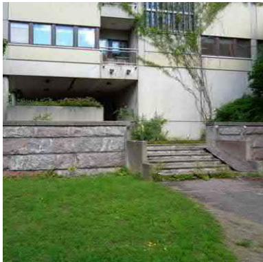
Uuden terveyskeskuksen lohkopintainen luonnonkivimuuri.
