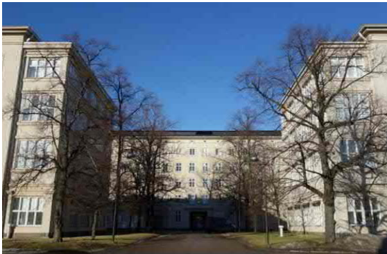
Keskiakseli nykytilassaan. Osa alkuperäisistä lehmuksista on säilynyt. Kulkuväylät on asfaltoitu, kulmat pyöristetty, arkadikäytävät rakennettu umpeen ja päätyparvekkeita korotettu.
