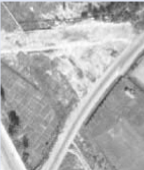
Reijolankatu rakenteilla. Läntisen Viertotien itäpuoli vielä viljelysmaata ja Urheilukadun pohjoisosa rakentamatta.
