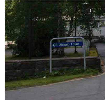
Luonnonkivimuuri (todennäköisesti alkuperäisistä osista tai hyvä jäljennös), rakennetaan uuden, Lääkärinkadulle johtavan tielinjauksen yhteydessä vuonna 1997. Lohkopintainen graniitti.
