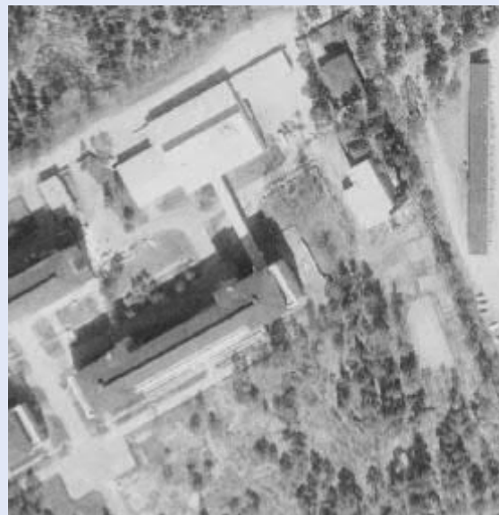
1950-luvulla sairaala-alueen koillisnurkka muuttui kertaheitolla, kun vanhan lämpökeskuksen paikalle rakennettiin uusi talousrakennus ja lämpökeskus huoltopihoineen. Pelikenttä ja hyötypuutarha säilyivät, vaikkakin lämpökeskuksen pysäköintipaikat levittäytyivät hieman kasvimaiden puolelle.
