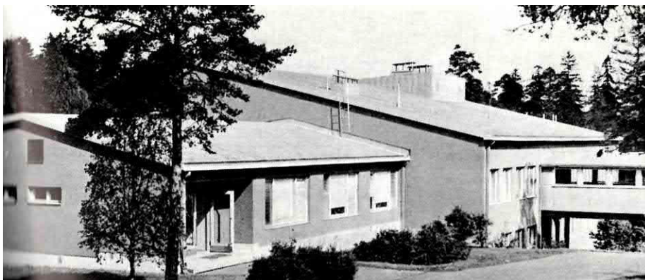
Laakson sairaalan talusrakennus lännestä päin katsottuna, 1960-luku, (Suomen sairaaloita)
