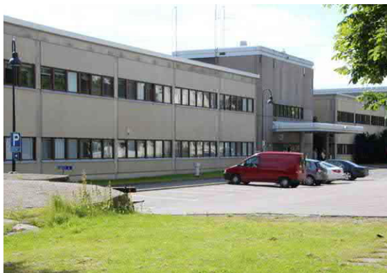
Terveyskeskuksen pääsisäänkäynti ja sen pohjoispuolelle sijoitettu pysäköintialue.
