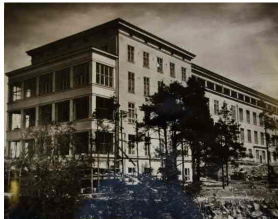
Tuberkuloosisairaalan rakennustyömaa vuonna 1929. (Arkkitehtuurimuseo)
