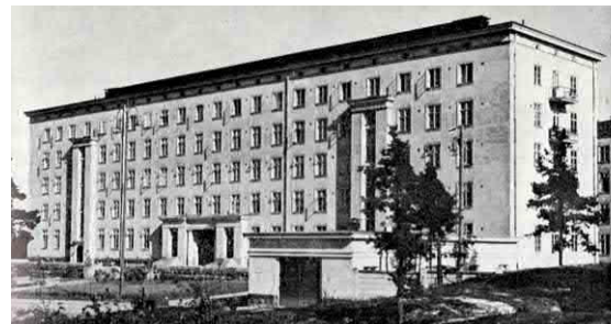
1. Pääsisäänkäynti hallintorakennuksen porttikäytävän läpi.
