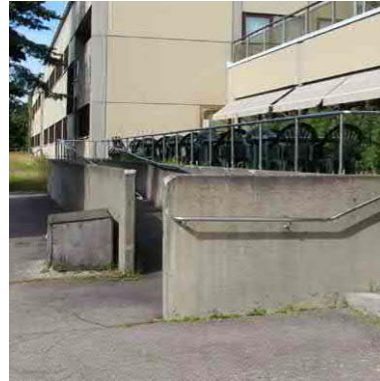
Terveyskeskuksen eteläpuoleisen terassin betonilaatat teräskaiteineen.
