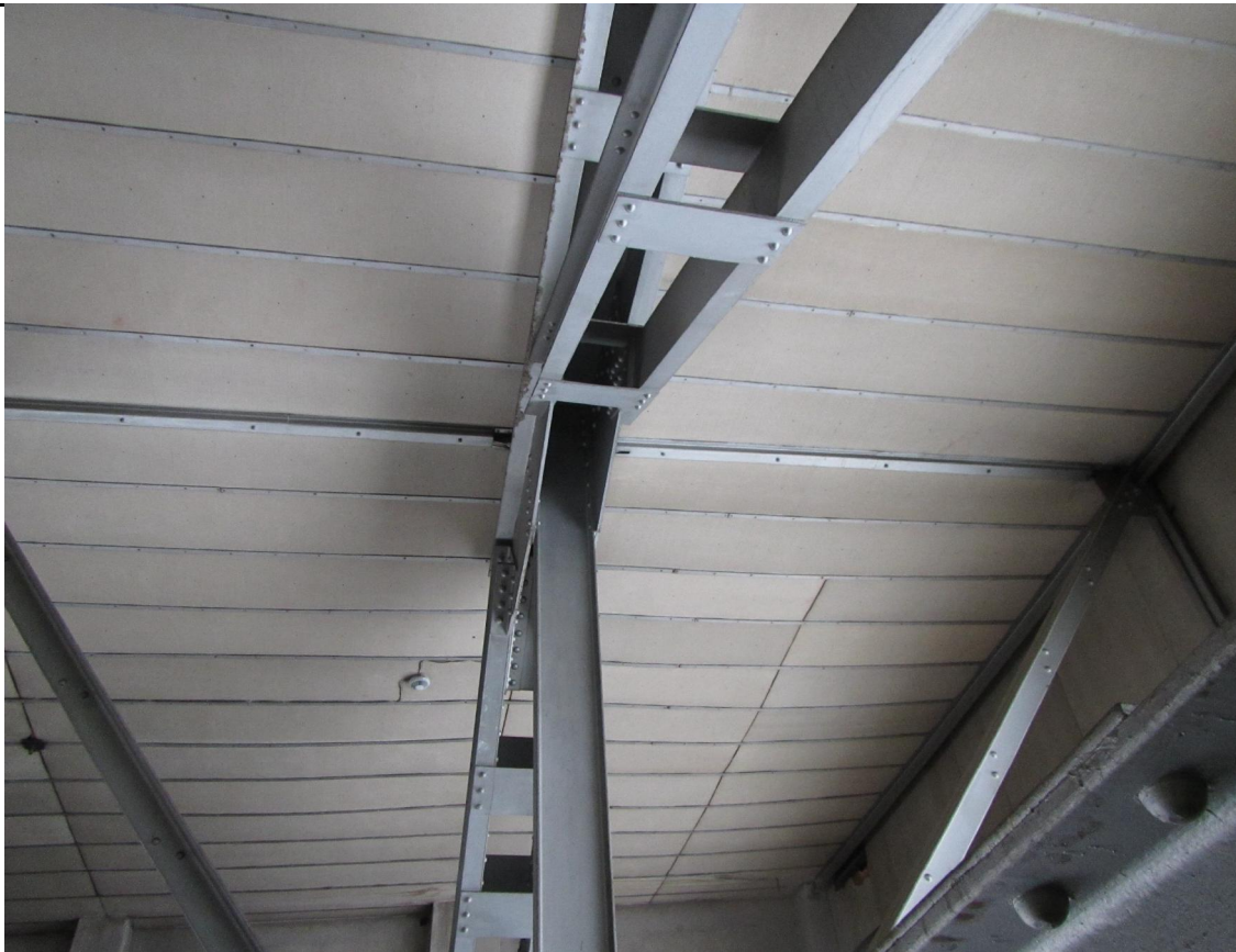
Kuva 1, Kattolevyjen kiinnitys. Hometta insuliittilevyissä ja ruostuneet puuruuvit
