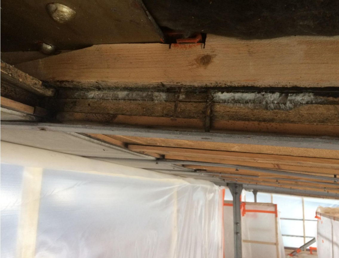
Kuva 1, Kattolevyjen kiinnitys. Hometta insuliittilevyissä ja ruostuneet puuruuvit
