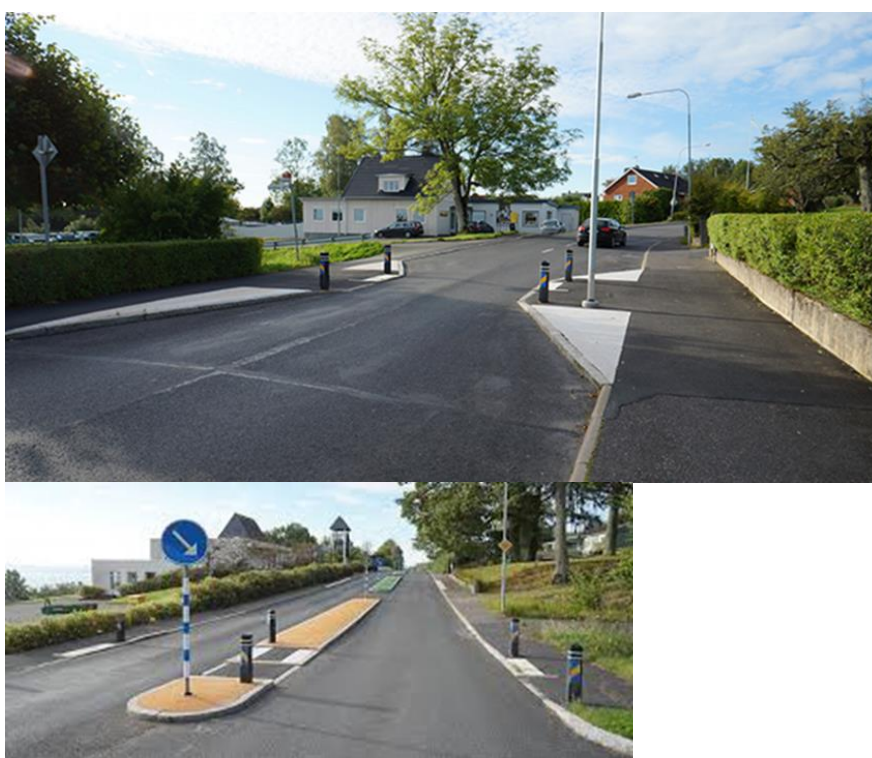
Kuva 15. Ruotsissa olevia suojatietttömiä kadunylityspaikkoja (gångpassage). Ylemmässä on käytetty kavennusta ja alemmassa keskisaarekettä. (Värmdö kommun 2017)
