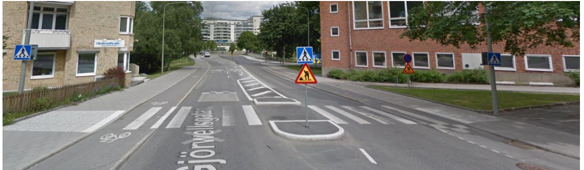
Kuva 7. Tukholmassa oleva suojatie, jonka turvallisuutta on parannettu kaventamalla ajorataa 1+1 kaistaiseksi ja lisäämällä tynnyhidaste suojatien eteen. Ylempi kuva tilanteesta ennen muutoksia ja alempi kuva muutosten jälkeen. (Google Maps 2019)
