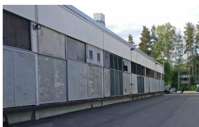
Kuva R-20. Itäjulkisivun vaneriverhoukset ovat huonokuntoisia.
