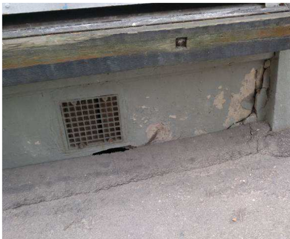
Kuva R-13. Sokkeleissa on tuuletusaukkoja.
