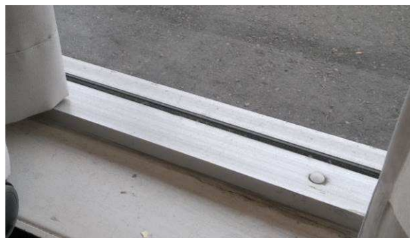
Kuva R-22. Vanha kuva. Näyteikkunat ovat yksilasisia.
