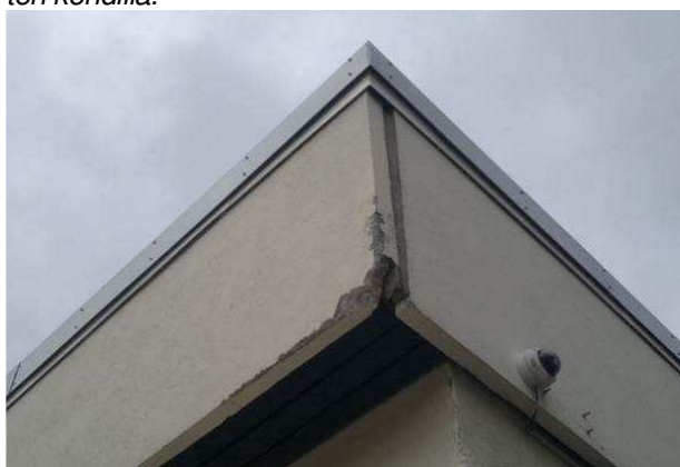
Kuva R-19. Vanha kuva. Kuorielementin mekaaninen vaurio.
