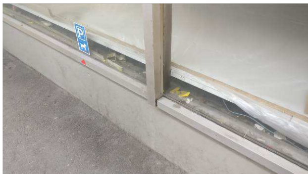
Kuva R-21 Ulkopuolen lasituslistoissa on vaurioita.
