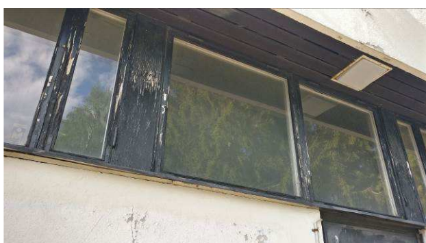
Kuva R-21 Ulkopuolen lasituslistoissa on vaurioita.
