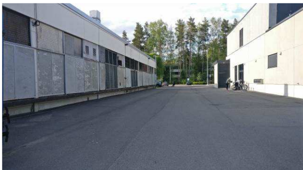
Kuva R-7. Takapihan uusittu asfaltti.
