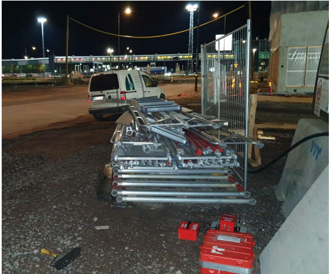
Kuva 5.3. Mittarin MP5 asennus maanvaraisesti betonilaatalle. Kuva on otettu raitiotien suuntaan.
