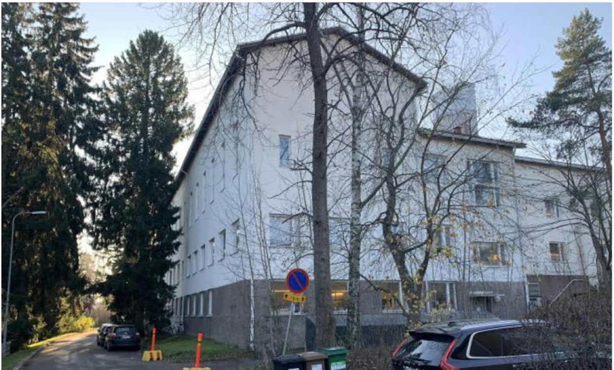
Näkymä pohjoisesta kohti rakennuksen säilyvän osan päätyä Kuva: Leppänen arkkitehdit Oy
