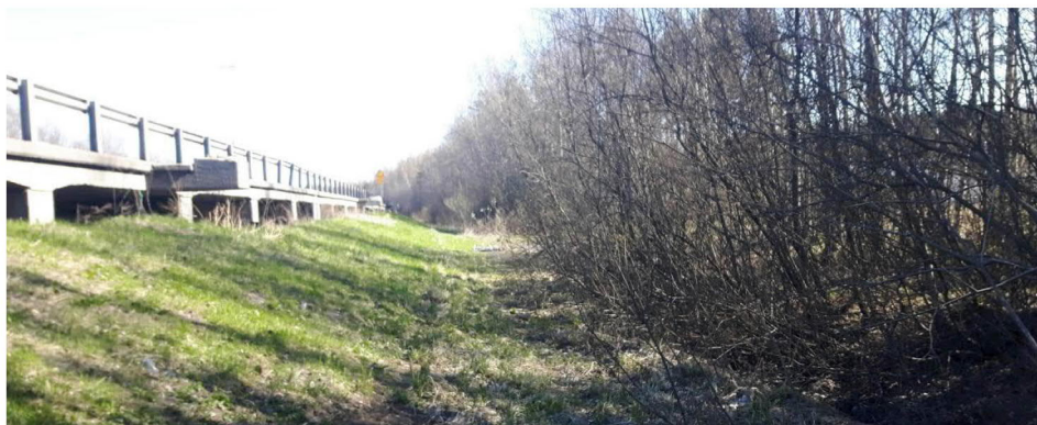
Kuva 43. Lahdenväylän ”maasilta”. Silta on erittäin pitkä ja sen alla on matala tila, jonka kautta eläimet voivat siirtyä Lahdenväylän poikki. Kuva: Lauri Erävuori.
