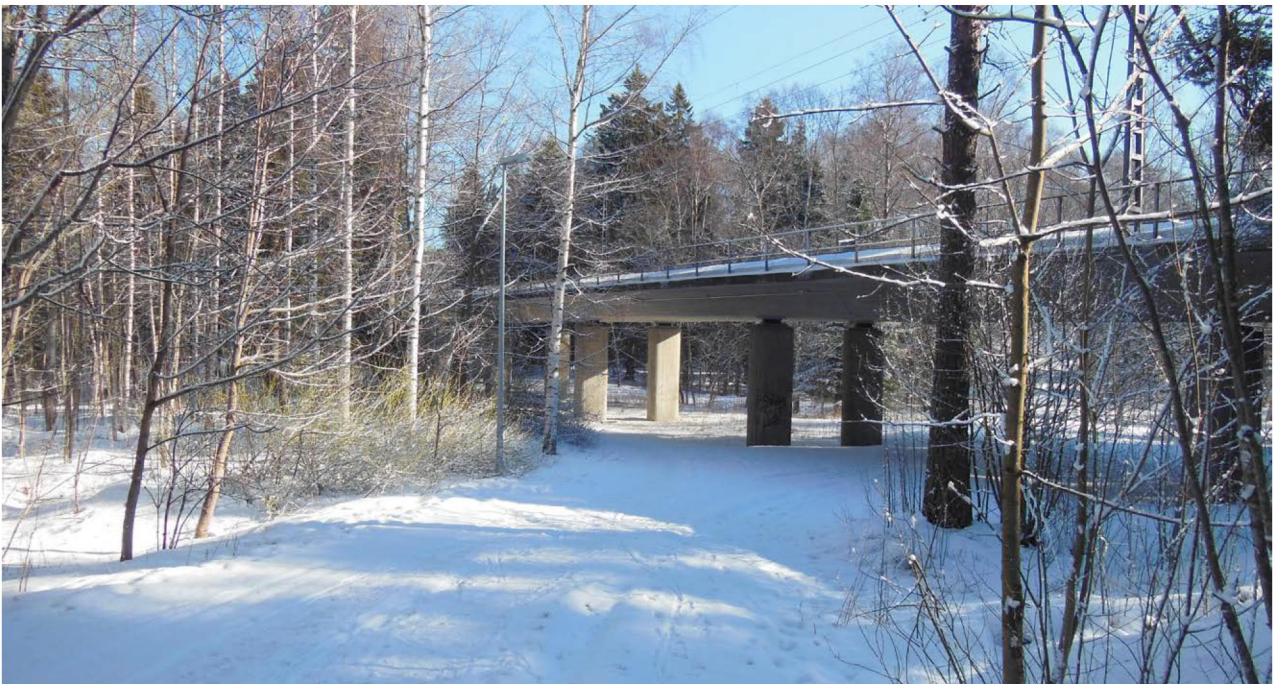
Kuva 35. Runsaan vapaan tilan jättävät siltarakenteet mahdollistavat myös luonnonympäristön jatkumon sillan allitse. Kuvan mukainen ratkaisu on esimerkki ekologisesti hyvin toimivasta ratkaisusta, joka palvelee monen kokoista eläimistöä. Kehärata, Pohjois-Haaga. Kuva: Lauri Erävuori.
