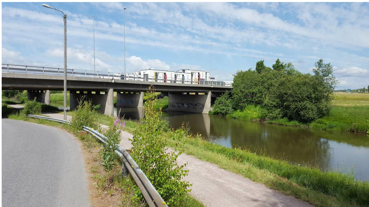
Kuva 33. Jokien ja vesistöjen ylityksissä siltarakenne on toteutettu siten, että rannoilla on sillan allittava makaistale, jota myöten eliölajit voivat liikkua jokivartta myöten. Tuusulan moottoritie, Vantaanjoen ylitys). Kuva: Tiina Saukkonen.
