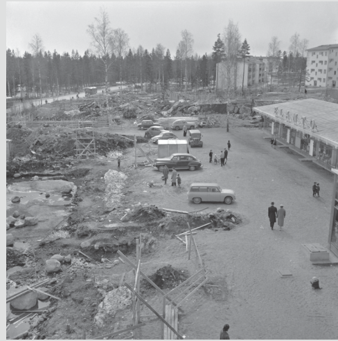
Rakenteilla oleva Roihuvuoren ostoskeskus.
