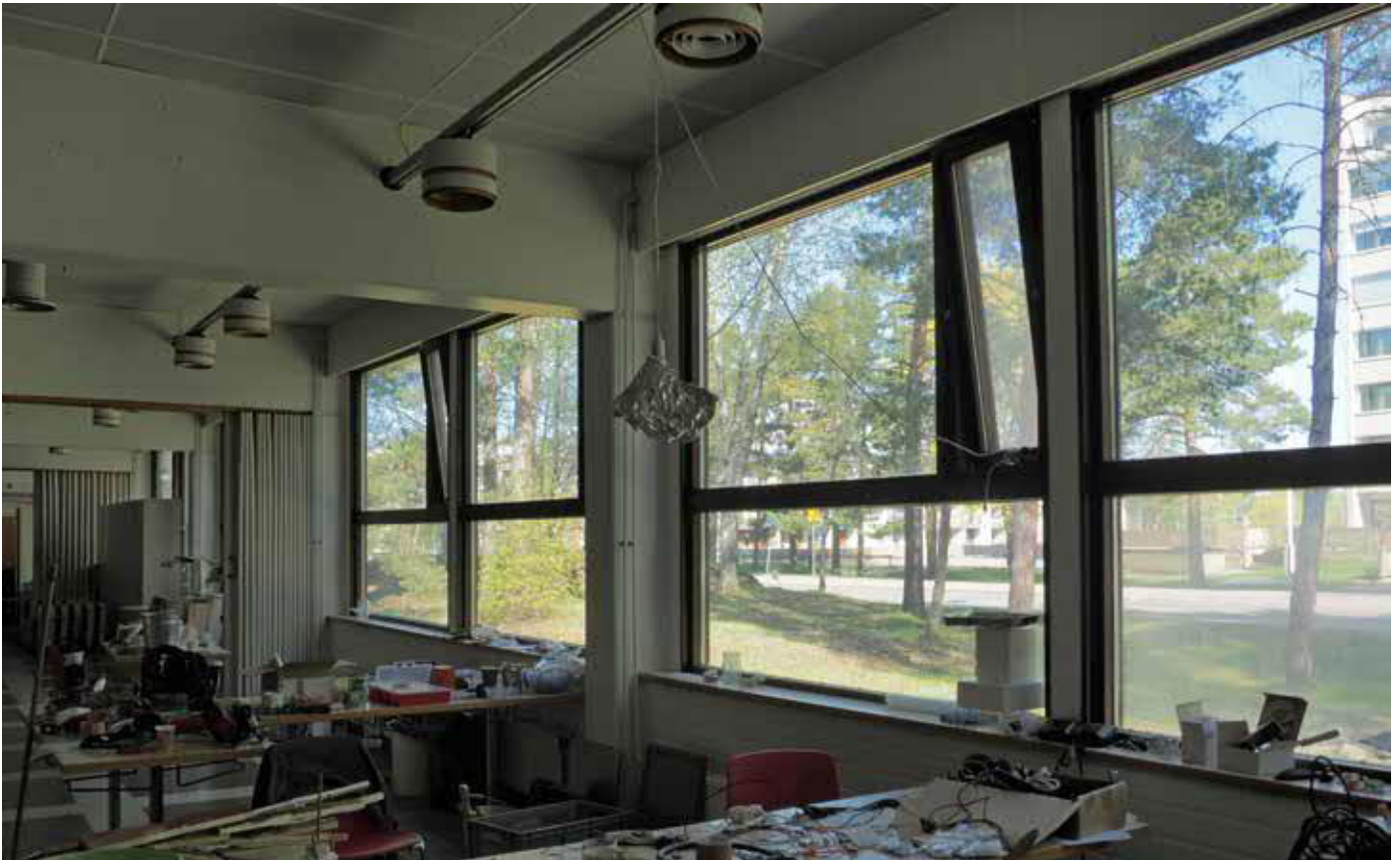
Tuuletusta tehostavat ikkunat ruokasalissa.
