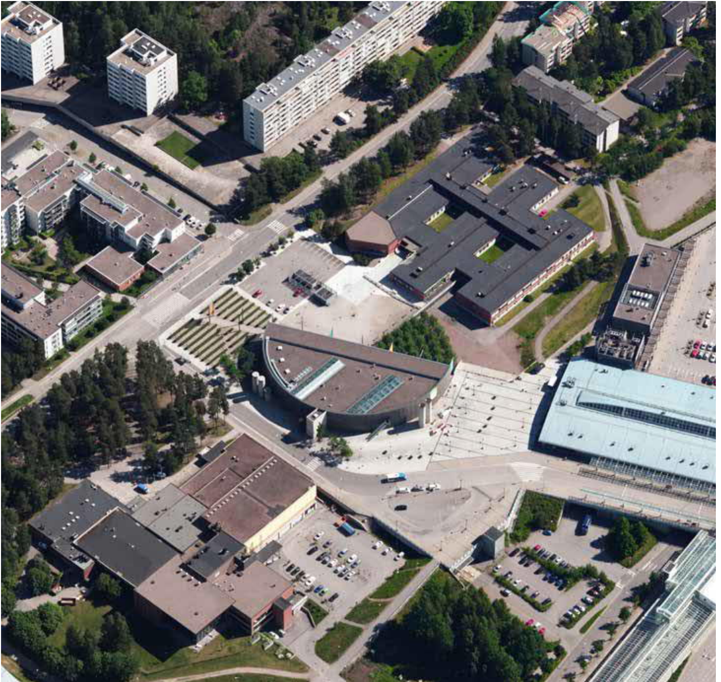
Tehtaanpuiston yhteiskoulun rakennus (ylhäällä oikealla) osana Vuotalon (keskellä) ja Vuosaaren Urheilutalon (vasemmalla alhaalla) kokonaisuutta. Koulurakennuksen ja Vuotalon välissä olivat koulun teknisen työn ja kotitalouden luokkatilat, jotka on yhdistetty osaksi Vuotalon toimintaa. Vuotalon alta johtaa maanalainen yhdyskäytävä Urheilutalon liikuntatiloihin. Helsinki KMO.
