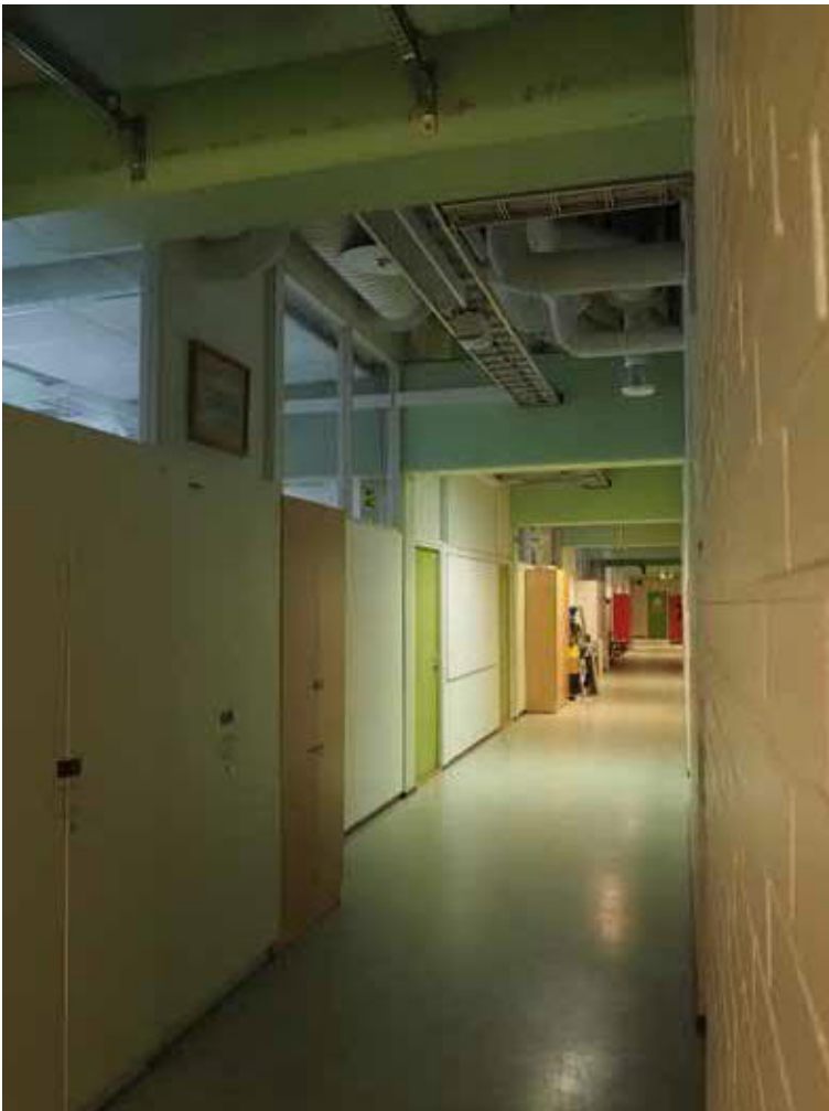
Pitkittäiskäytävät kulkevat rakennuksen rungon sisällä ja saavat valoa luokkatilojen yläikkunoista.
