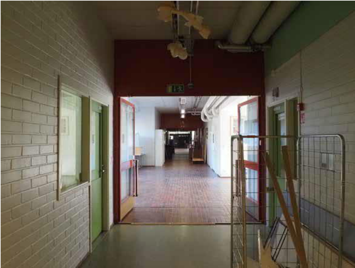
Poikittäiskäytävät kulkevat valoisten aulatilojen läpi.
