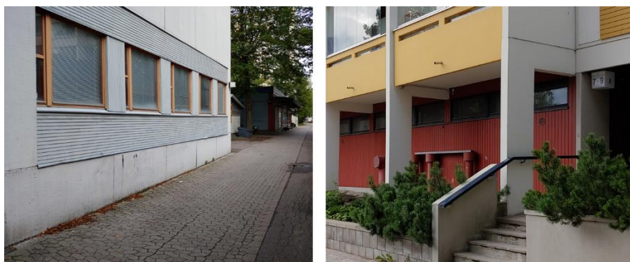
Alueen nykyisten rakennusten maantasokerroksen julkisivuissa on jalankulkuraitin varrella käytetty puuverhousta. Vas. Purpuripolku 3, oik. Purpuripolku 7.
