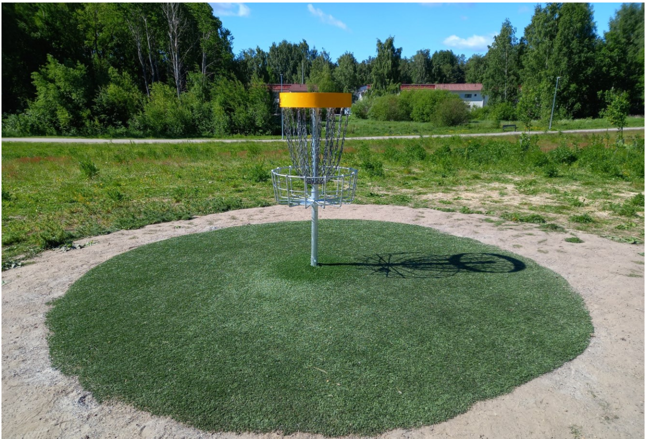
Kuva 11. Maalikorin ympärys kannattaa päällystää halkaisijaltaan 4 metrin hiekkatekonurmella, jotta korin ympärys kestäisi kulutusta.
