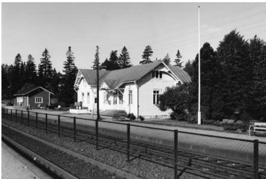
Asemarakennus ja tavaramakasiini vuonna 1963. Junaradan sähköistyksen myötä asemalaiturilla ollut tavaramakasiini purettiin ja sen tilalle rakennettiin pysäköintialue.
