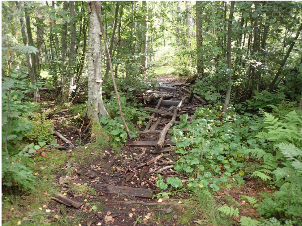
Kuva 19 Vanhat pitkokset ja muut rakenteet poistetaan korvesta.
