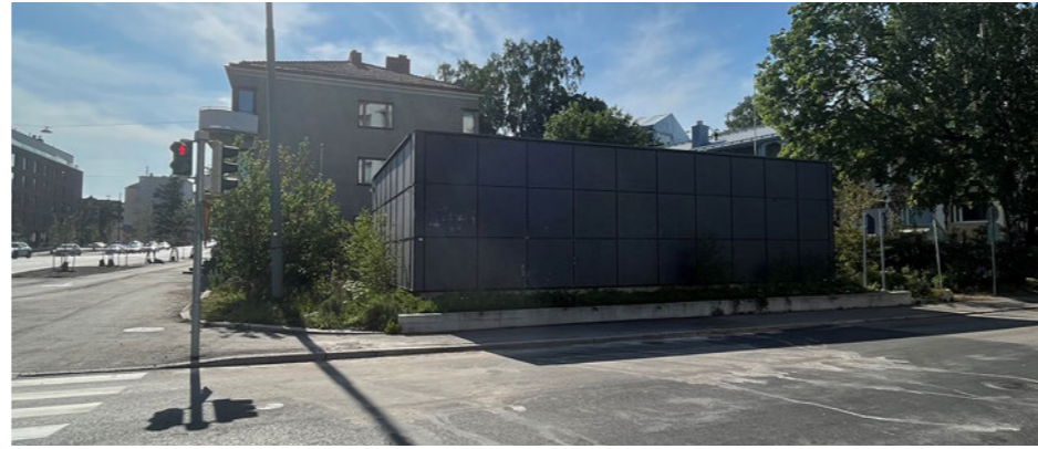
Kuva 2.10 Esimerkki Lauttasaassa sijaitsevasta Länsimetron kuilurakennuksesta, jossa ratatunnelia palvelevaa tekniikkaa on viety mahdollisimman paljon maan alle. Maanpäällisen rakennuksen pituus on noin 16 metriä, leveys noin 12 metriä ja korkeus noin 4 metriä. (Kuva: Sitowise Oy)
