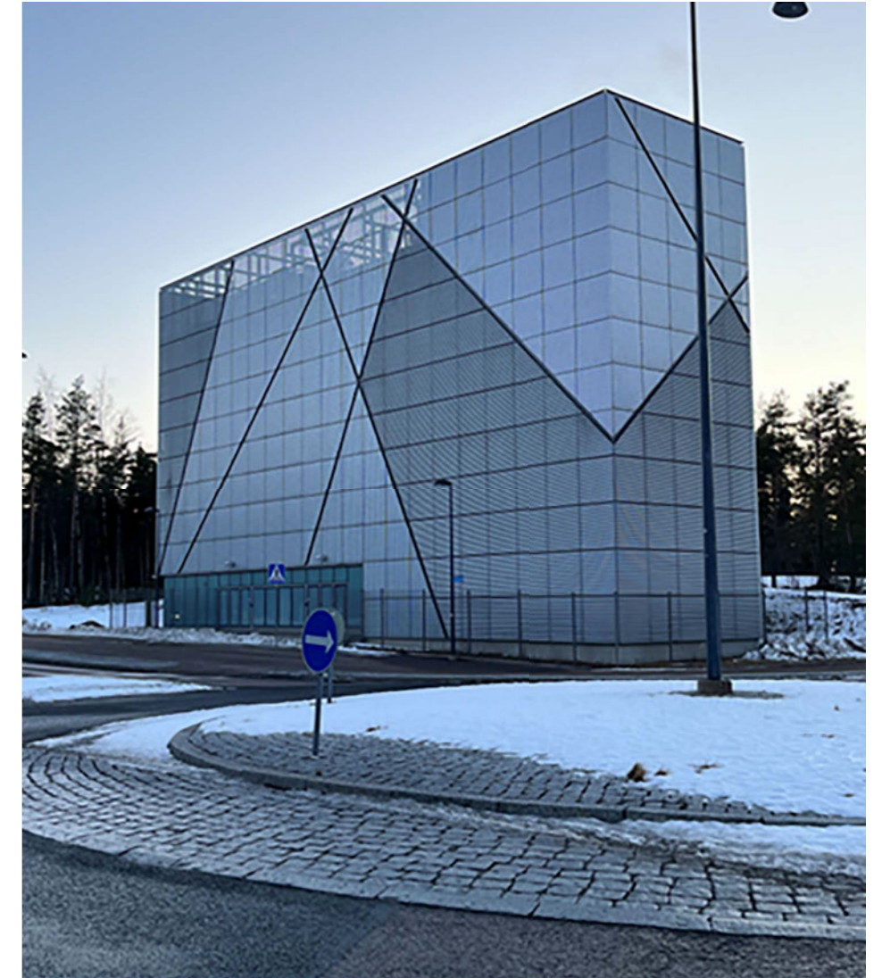
Kuva 2.12 Vantaan Aviapoliksessa sijaitseva Kehäradan tekninen kuilurakennus, jossa ratatunnelia palvelevaa tekniikkaa on sijoitettu maanpäälliseen rakennukseen. Maanpäällisen rakennuksen pituus on noin 33 metriä, leveys noin 8 metriä ja korkeus noin 18 metriä. (Kuva: Sitowise Oy)
