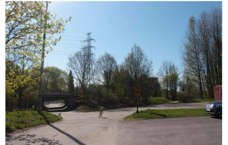
Talin alikulku. (Kuva: Lotta Aulamo)
