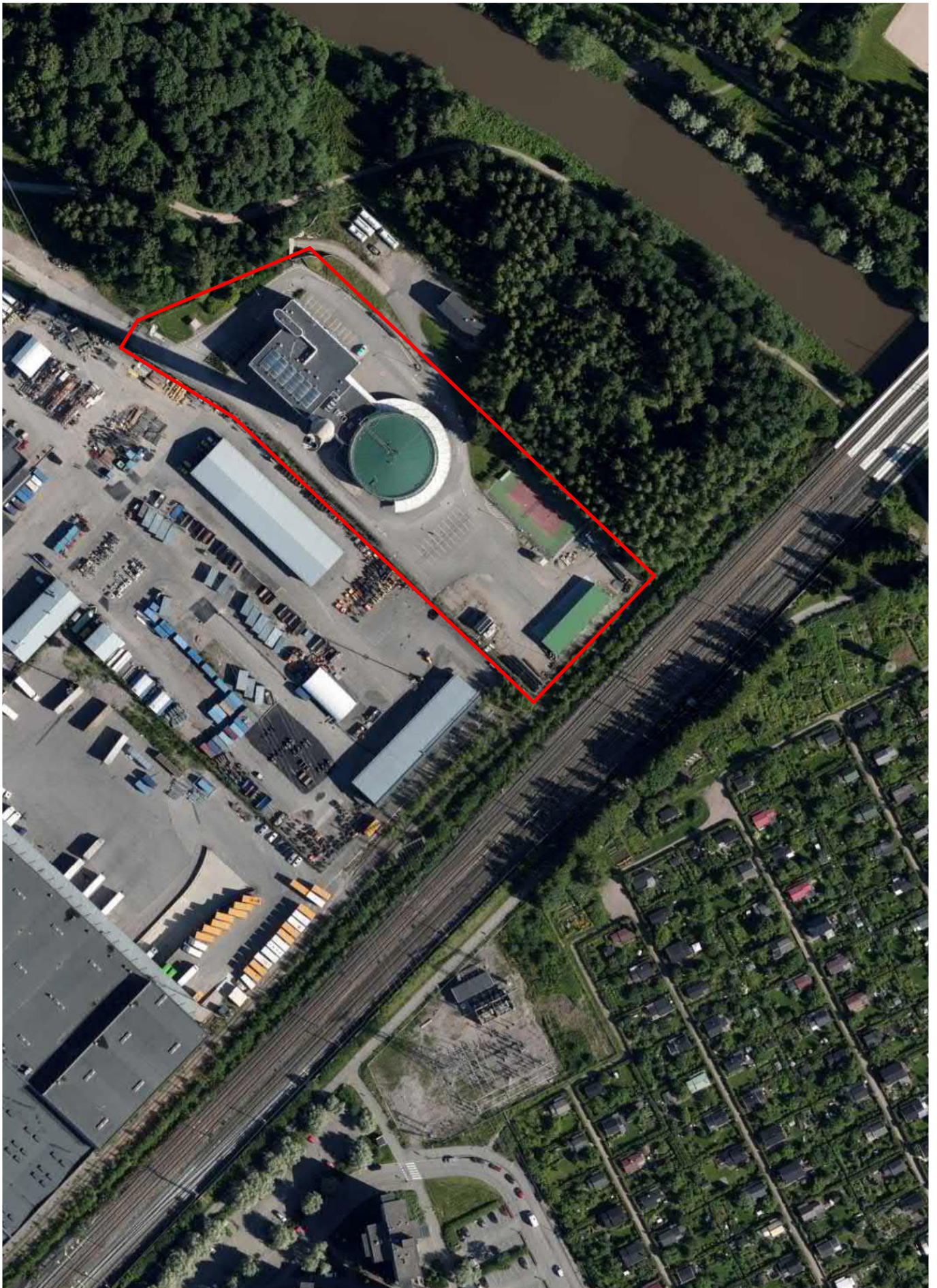
Ilmakuva Oulunkylä Lämpökuja 6
