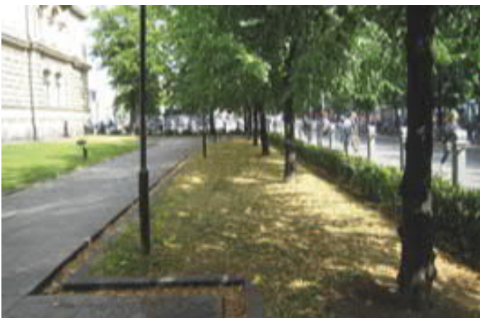
Ateneumin puistikkojen luonnonkivettyjen kulkuväylien reunoissa on luonnonkiviset hulevesikourut.
