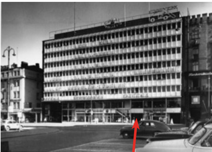
C2) Kaivotalon sisäänkäynti
