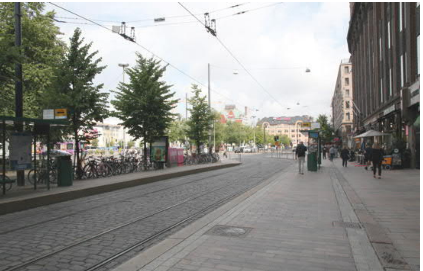
Mikonkadun ajorata ja jalkakäytävät on päällystetty kokonaisuudessaan luonnonkivellä, myös raitiovaunupysäkkien huomioraidat on ladottu valkoisesta luonnonkivestä. Päällysteiden yhtenäisyys edesauttaa viimeistellyn vaikutelman syntyä. Harmillisesti kalusteiden ja varusteiden kirjo peittää näkymiä kadulta Rautatien suuntaan.
