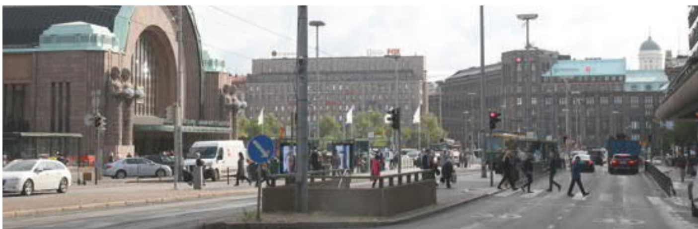
Kaivokadulle on vuosien saatossa asennettu runsaasti rakenteita ja pystytetty erinäisiä pylväitä. Asfalttipinnoite ja maalatut suojatiet ovat kuluneita. Yleisilme on sekava ja epäsiisti.
