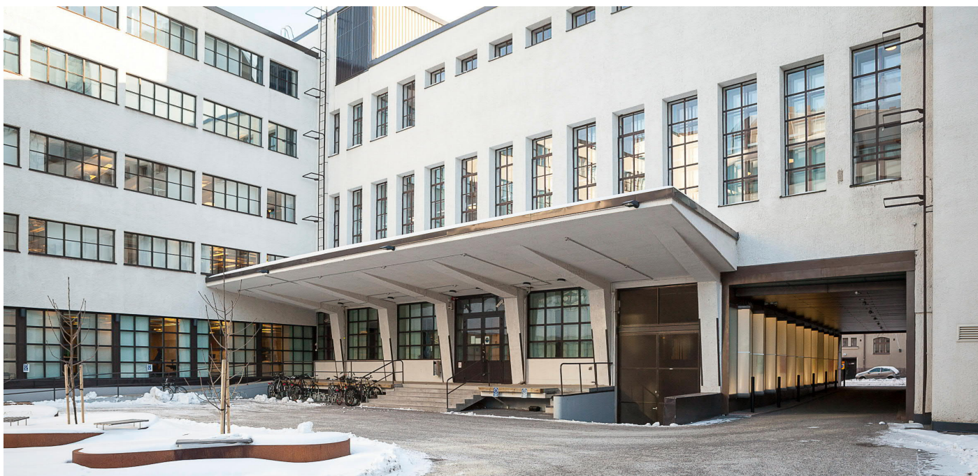
Leipomo korttelin sisäpihalta nähtynä. Vasemmalla laajennusosa.
