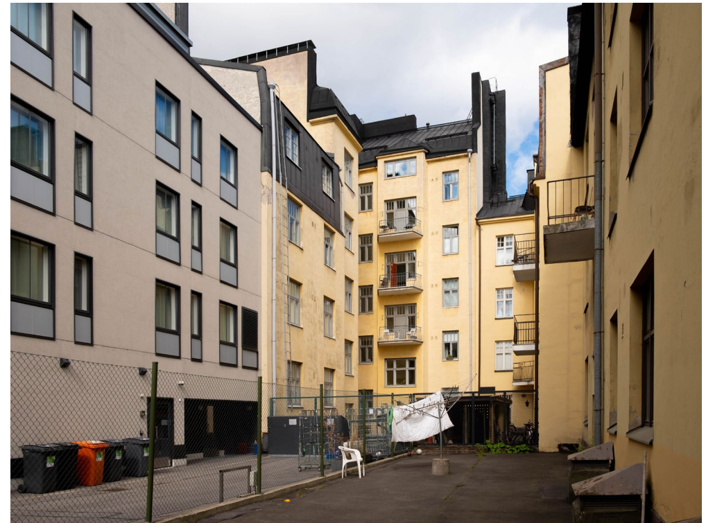
Bulevardi 24:n sisäpiha
