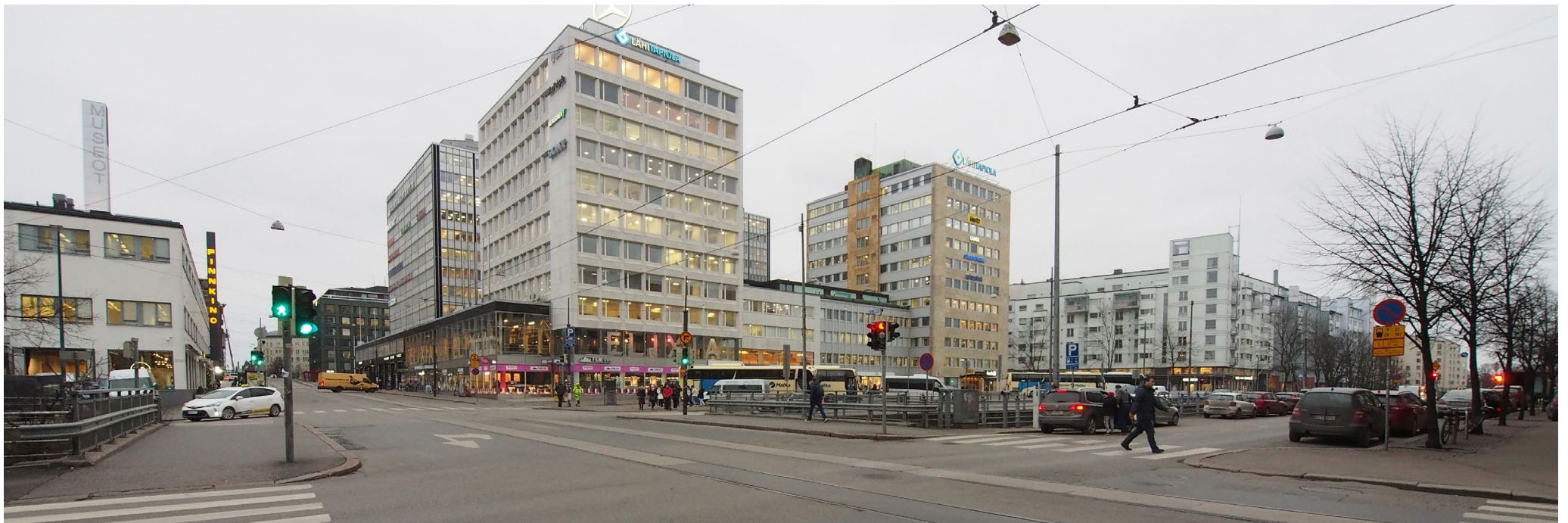
Autotalon kortteli koillisesta, etualalla Kampintorni Oy:n liiketalo (Risto-Veikko Luukkonen 1962).
