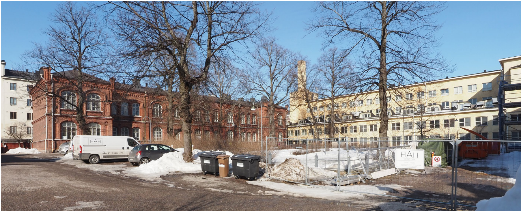
Ylhäällä vasemmalla: Marian sairaalan hallintorakennus ja paviljonki, Lapinlahdenkatu 16 (Lars Sonck 1909). Ylhäällä oikealla: Ressun lukion juhla- ja voimistelusalisiipi, Kalevankatu 10 (Sebastian Gripenberg, E. Törnvall 1894). Alhaalla: Kaartin lasaretin päärakennus (Evert Lagerspetz 1884) ja entinen VTT:n laboratoriorakennus (Jussi Paatela 1942).
