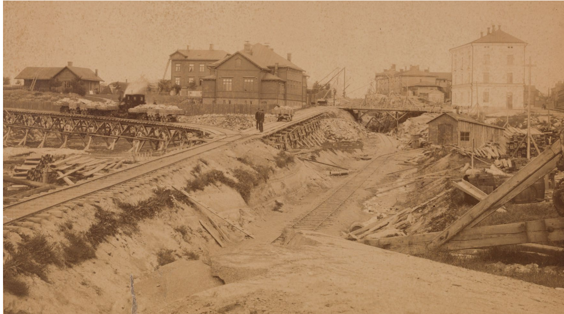
Satamaradan työmaa Leppäsuon kohdalla vuonna 1905. HKM
