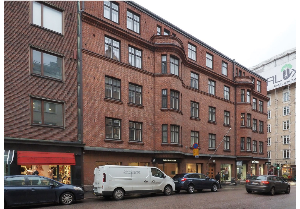
Fredrikinkatu 38:n (M. Olin 1924) julkisivusommittelussa on edellisen vuosikymmenen arkkitehtuurin piirteitä.
