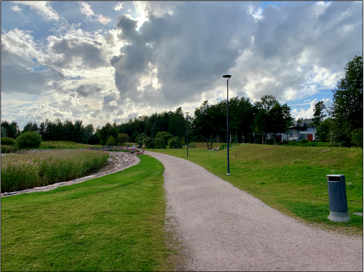
Kuva 5.2.1-1. Nuottaniemen tulvasuojaus Espoossa valmistui vuonna 2020.
