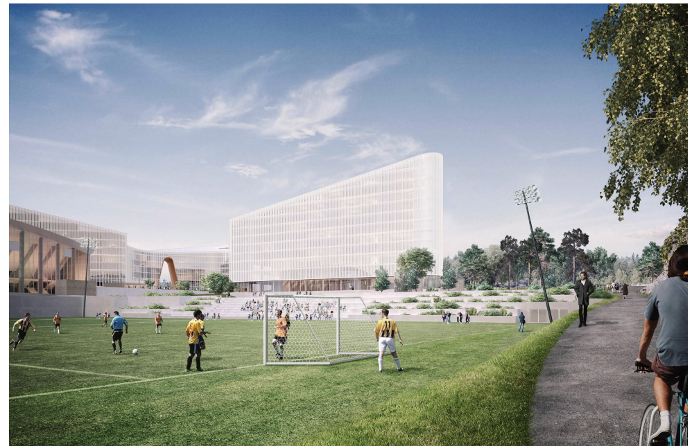
NÄKYMÄ ETELÄSTÄ PALLOKENTÄLTÄ 6
