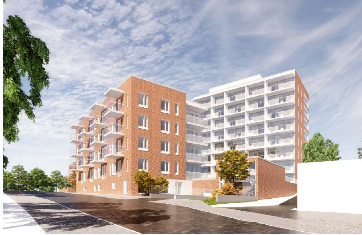
Kuva 12. Havainnekuva osoitteeseen Laurinmäenkuja 3 suunnitellusta uudesta asuinrakentamisesta. Kuvälähde: Arkkitehdit Anttila & Rusanen Oy / Lujatalo Oy
