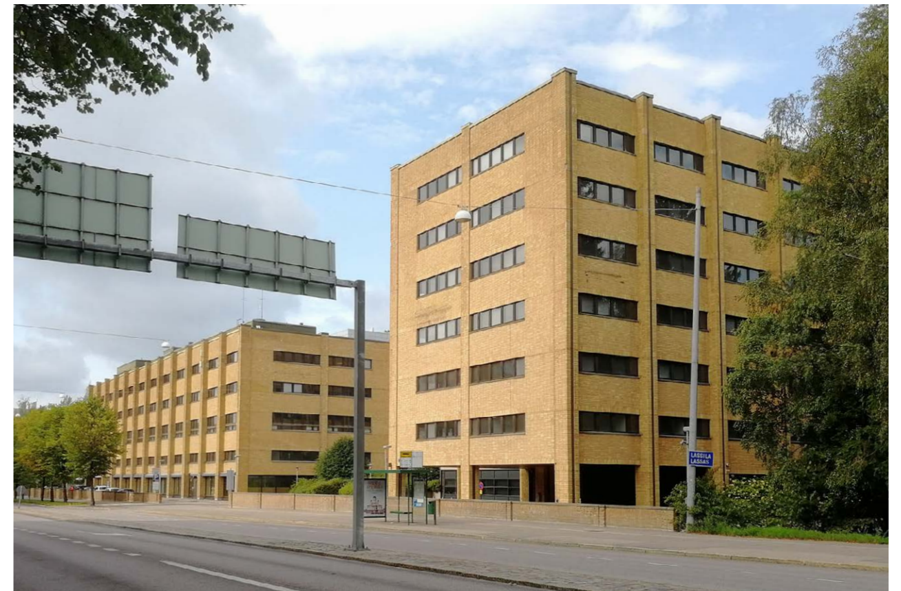
Kuva 1. Näkymä Kaupintien alkupäästä kohti osoitteessa Kaupintie 3 sijaitsevia kiinteistöjä.
