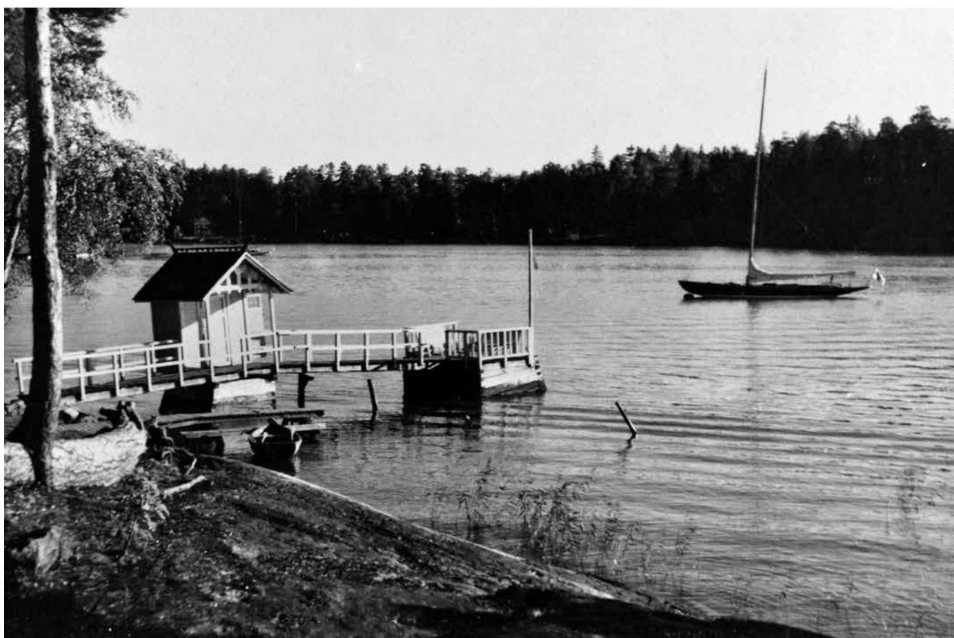
Draknäsin huvilan hirsiaarkkulaituri uimahuoneineen kuvattuna 1930-luvulla. HKM
