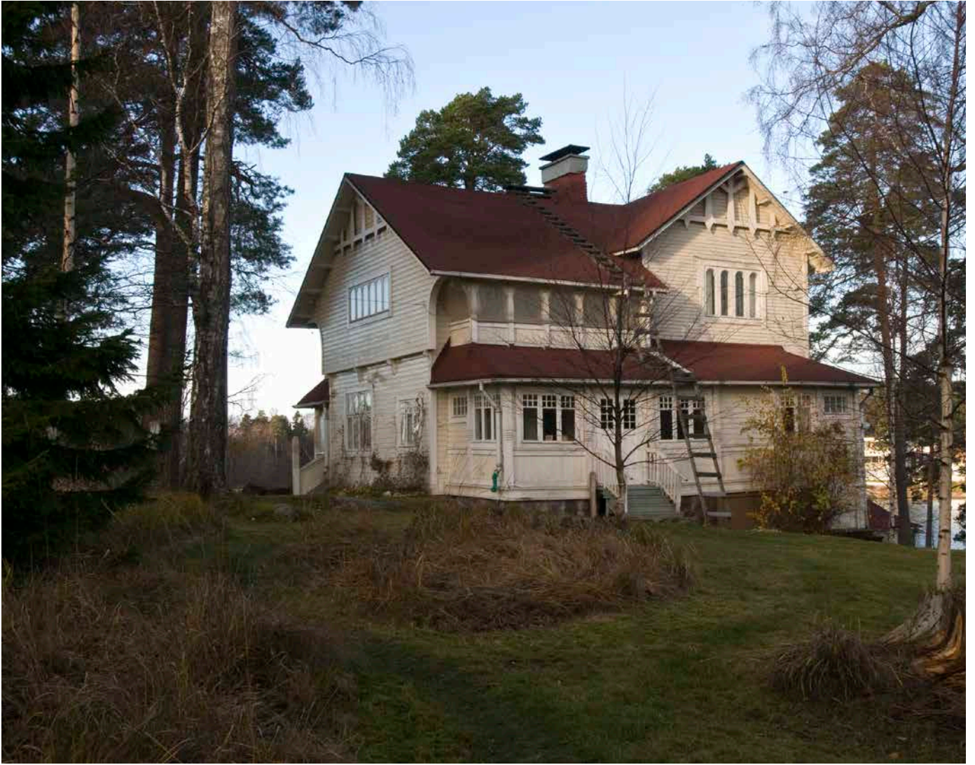
Stenkullan julkisivuissa on 1800-luvun lopulle tyypillisiä aiheita, erikoisia holvikaari-ikkunoita ja yläkerrassa avoimet galleriat. Jugend-ikkunat ja pihan puoleinen kuisti ovat mahdollisesti peräisin muutostyöstä 1900-luvun alussa. Päättydetaljit ovat samat kuin Villa Draknäsin julkisivussa. Kari Hakli 2011.
