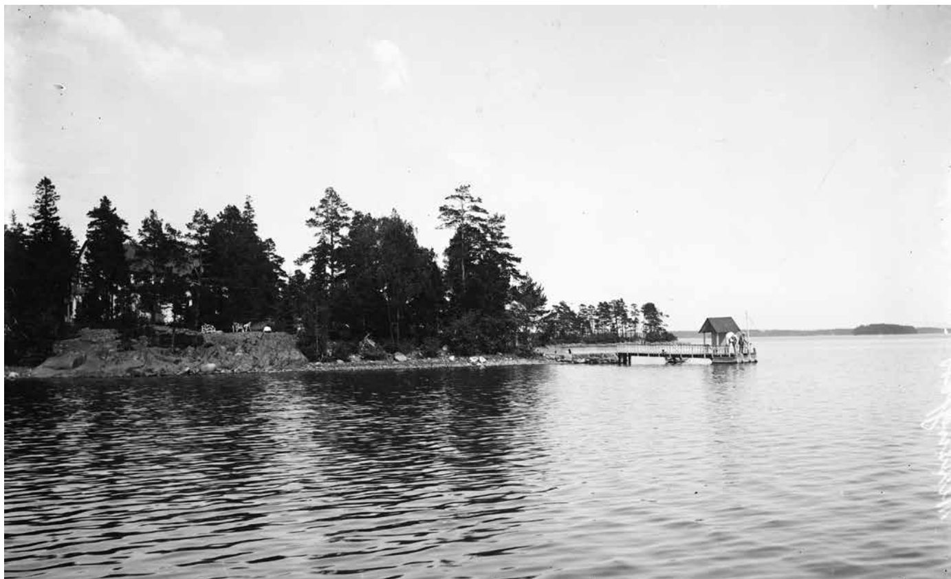
Drakudden, tuulisen niemen kärkeen oli rakennettu hirsiaarkkulaituri uimahuoneineen ja liikennesignaaleineen. MV, kuvausvuosi tuntematon
