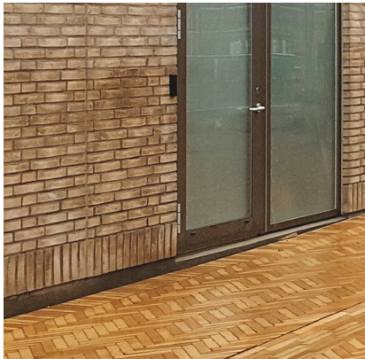
TIILIMUURAUUS, MATALA SOKKELI JA MAATIILI
