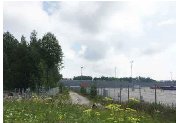
A | Suunnittelualueella olevalta kylmäasemalta kohti Metrovarikkoa
