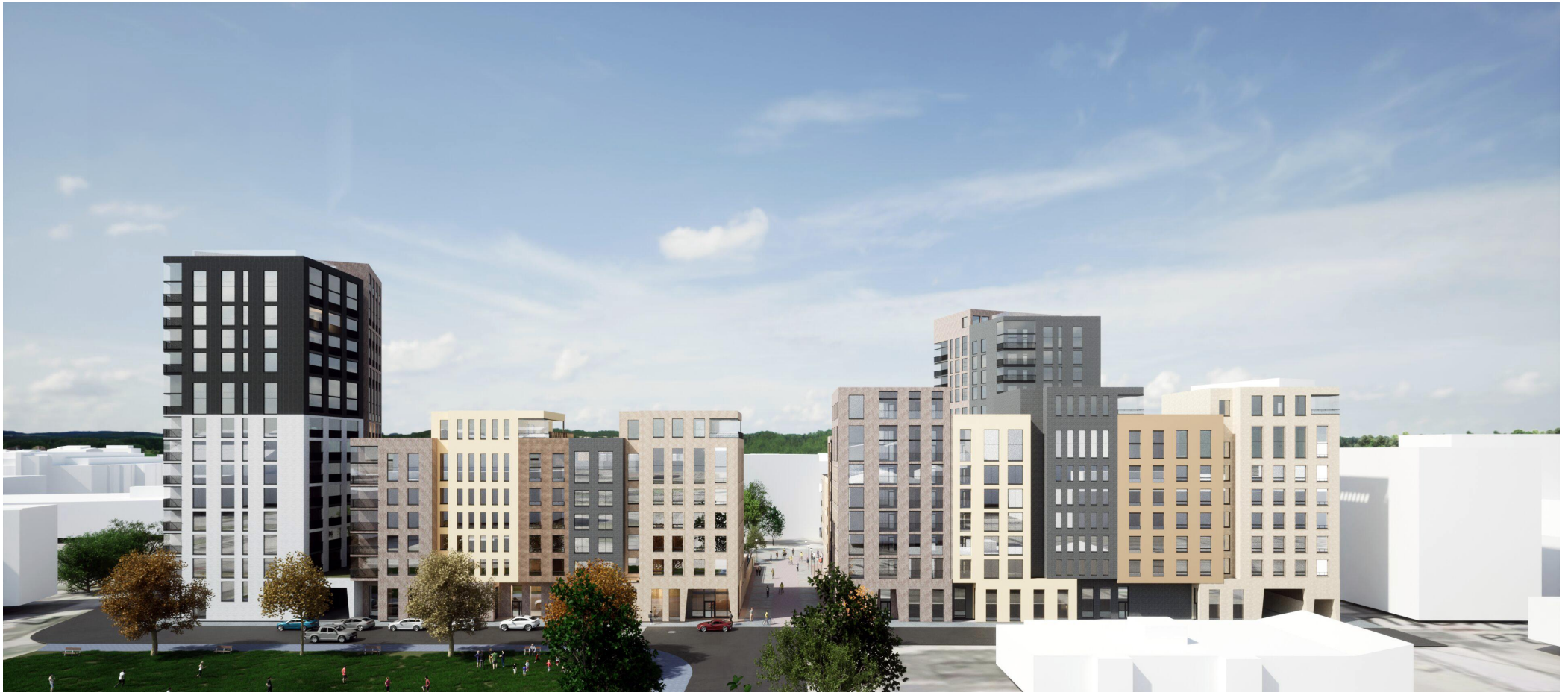
Aluejulkisivu lännestä katsottuna.
